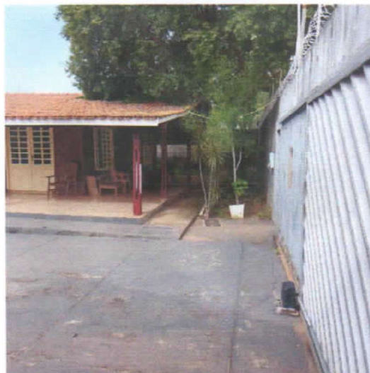
Foto 4 - Imóvel Avaliando - Rua Dom Mario Andreazza, 204. Três Poderes. 5°30'56.37° - 47°28'40.02°O
