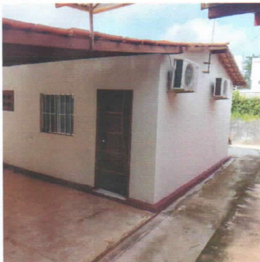
Foto 7 - Imóvel Avaliando - Rua Dom Mario Andreazza, 204. Três Poderes. 5°30'56.37° - 47°28'40.02°O
