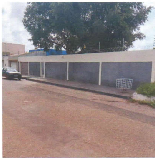
Foto 2 - Imóvel Avaliando - Rua Dom Mario Andreazza, 204. Três Poderes. 5°30'56.37° - 47°28'40.02°O
