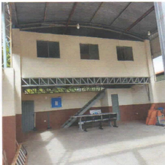
Foto 10 - Imóvel Avaliando - Rua Dom Mario Andreazza, 204 – PARTE QUE DÁ ACESSO À RUA RIO DE JANEIRO . Três Poderes. 5°30'56.37° - 47°28'40.02°O
