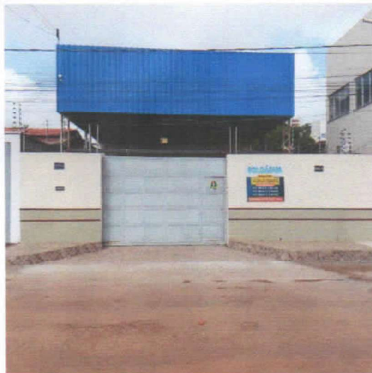
Foto 9 - Imóvel Avaliando - Rua Dom Mario Andreazza, 204 – PARTE QUE DÁ ACESSO À RUA RIO DE JANEIRO . Três Poderes. 5°30'56.37° - 47°28'40.02°O
