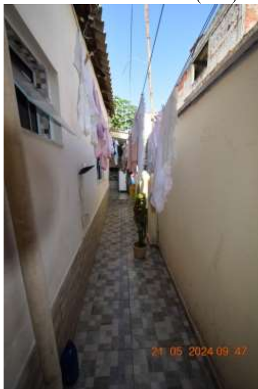
Corredor lateral dando acesso aos fundos do imóvel (lavanderia e espaço de despejo).
