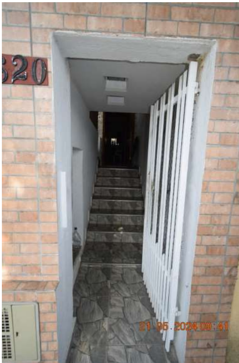
Escada de acesso ao interior do imóvel.
