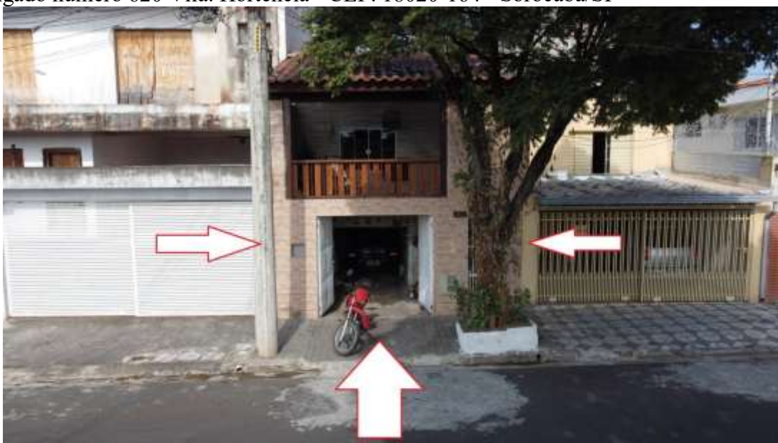
Vista frontal do Imóvel Avaliando
