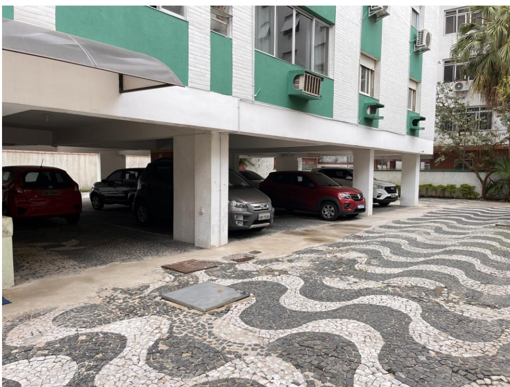
Figura 5: Área de garagens.
