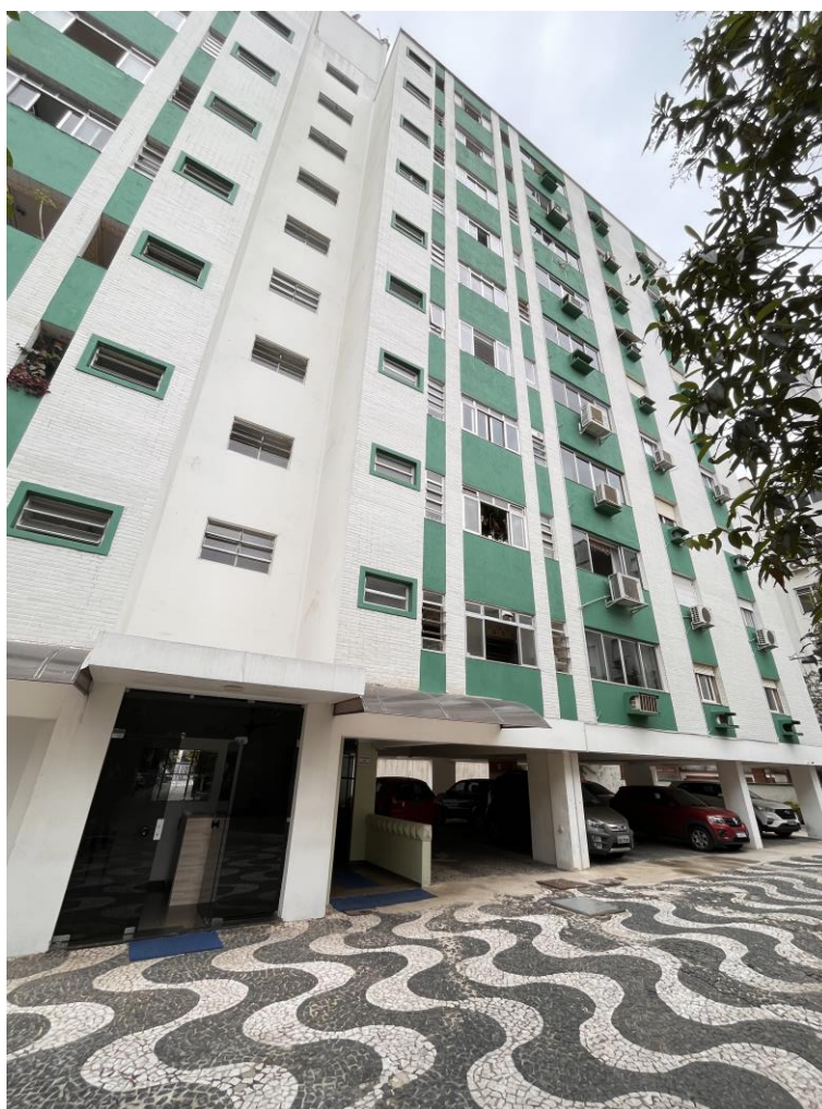
Figura 3: Vista do Edifício Tocantins.
