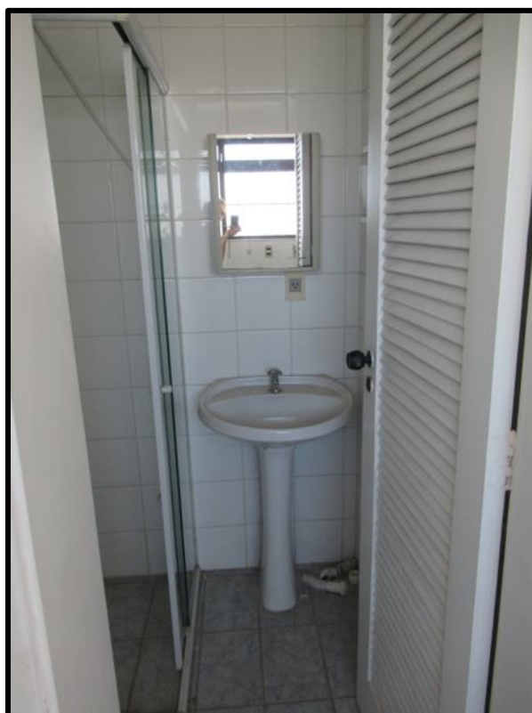
Foto 15: Banheiro de serviço
