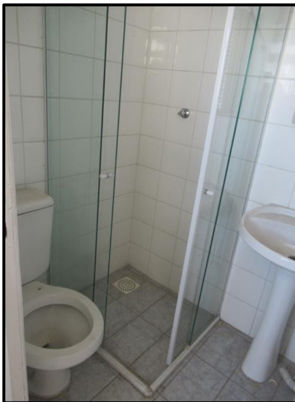
Foto 16: Banheiro de serviço
