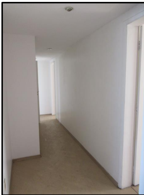
Foto 51: Corredor dos quartos
