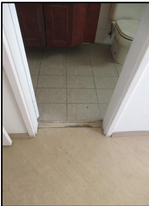
Foto 38: Piso da entrada do banheiro
