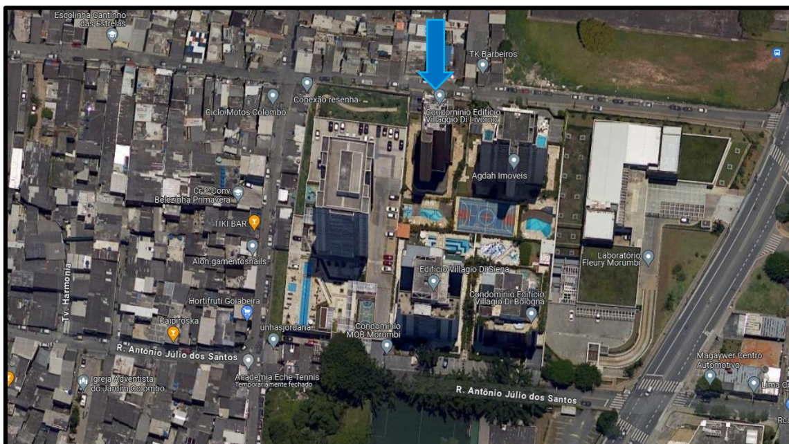
Figura 2: Vista aérea da localização do Condomínio Edifício Villaggio Di Livorno
