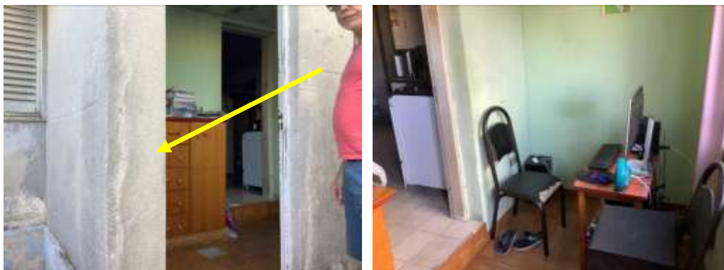
Vista entrada unidade fundos e sala.
