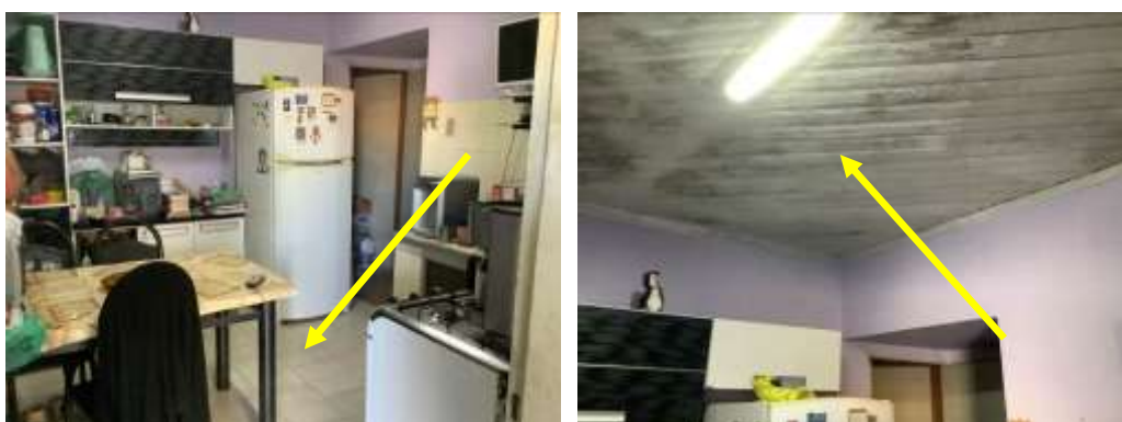
Vista parcial da cozinha – piso e teto.
