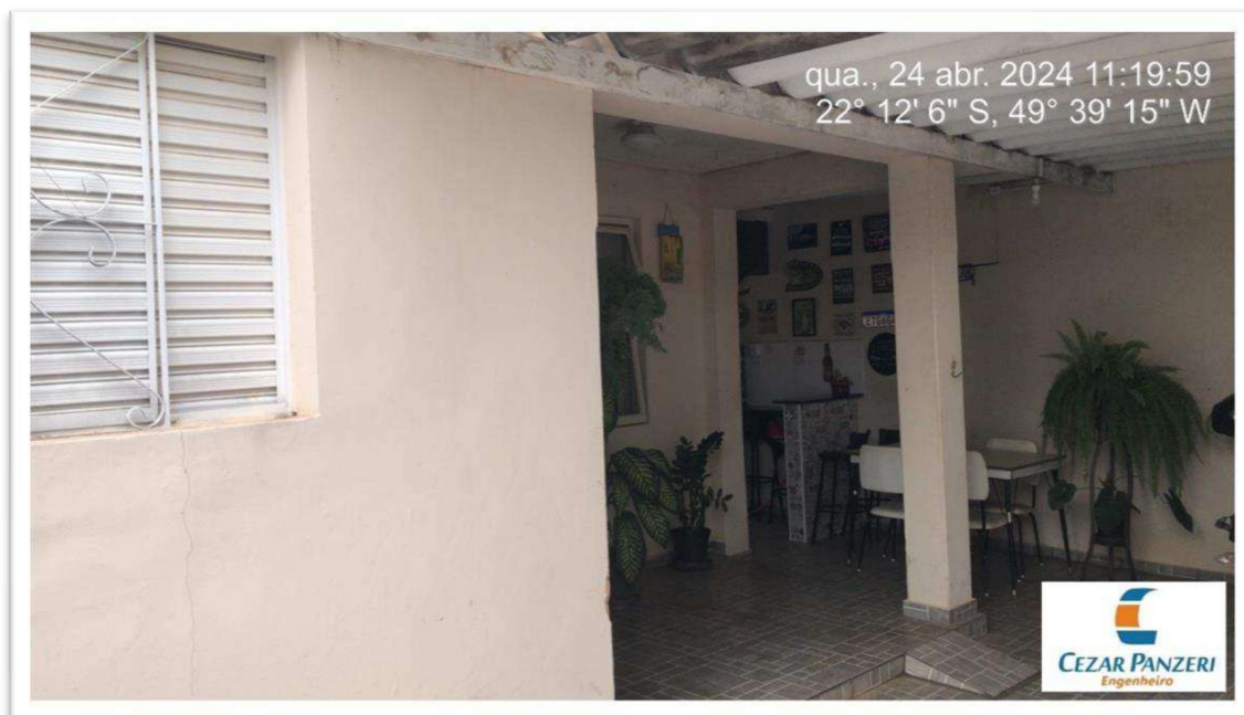
Figura 3 – Fachada do acesso a residência - Fonte: Perícia.
