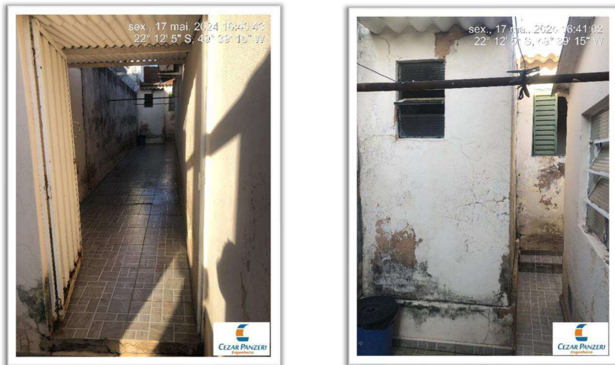
Figura 12 – Corredor com acesso a edícula- Fonte: Perícia.
