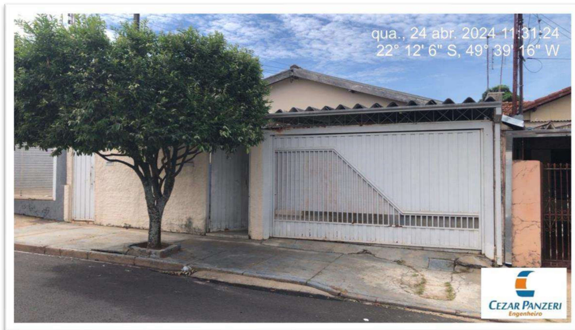
Figura 1 – Identificação da Fachada da Edificação - Fonte: Perícia.
