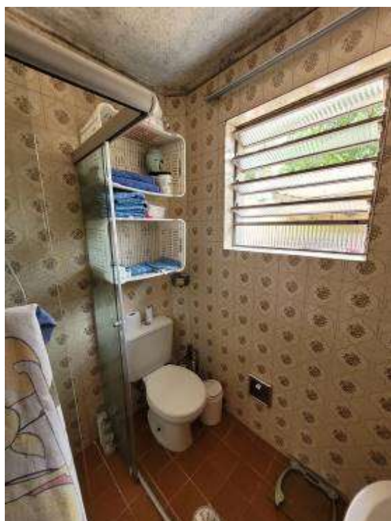
Aspectos parciais do banheiro (suíte).
