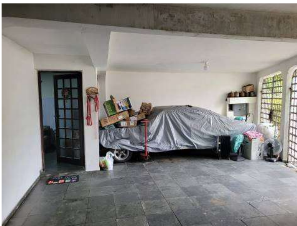
Aspectos parciais da garagem.
