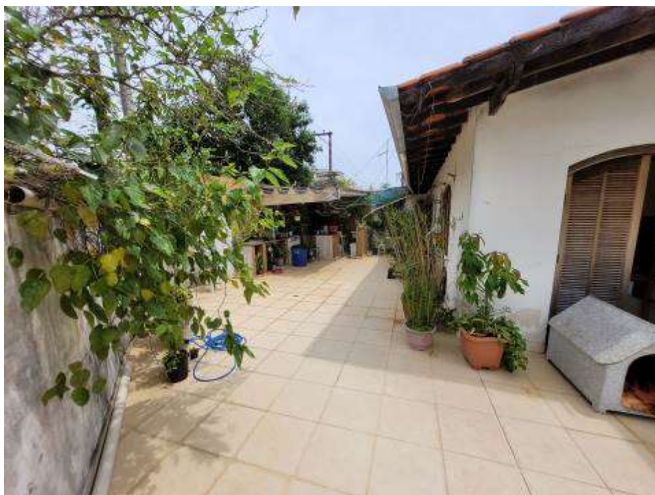
Aspectos parciais do terraço.
