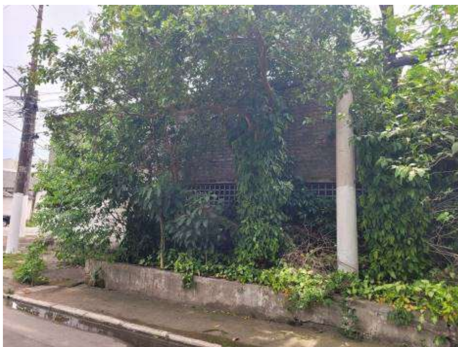
Aspectos da fachada lateral do imóvel avaliando.
