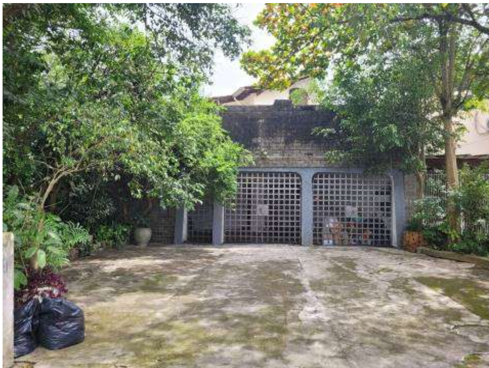
Aspectos da fachada frontal do imóvel avaliando.
