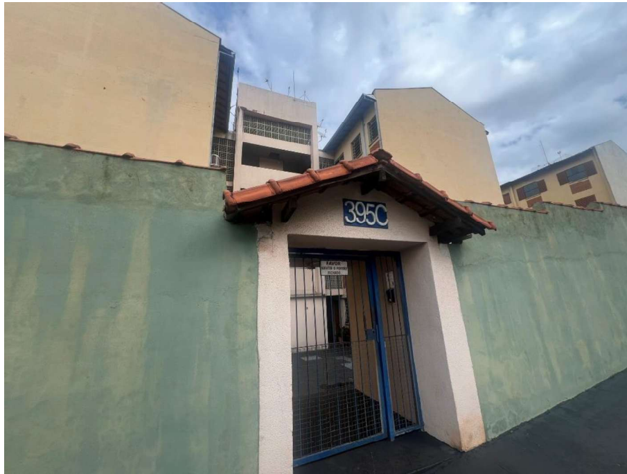
Foto 3 - Vista da fachada/entrada do bloco
