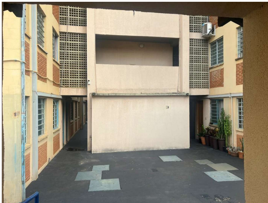
Foto 4 - Vista interna do bloco onde situa-se o avaliando
