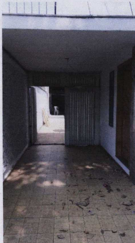
Foto 07 - Vista frontal da garagem do imóvel vistoriando.
