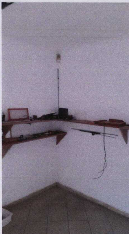
Foto 15 - Vista do segundo dormitório do imóvel vistoriando.
