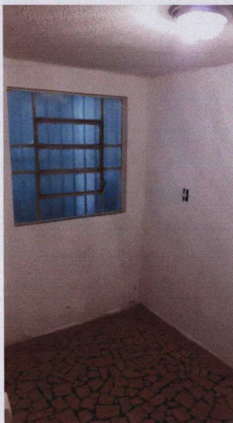
Foto 29 - Vista do segundo cômodo da edícula do imóvel vistoriando.
