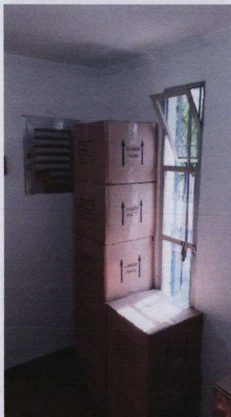
Foto 10 - Vista da antecâmara do imóvel vistoriando.
