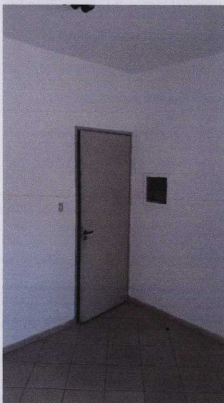
Foto 18 - Vista do terceiro dormitório do imóvel vistoriando.
