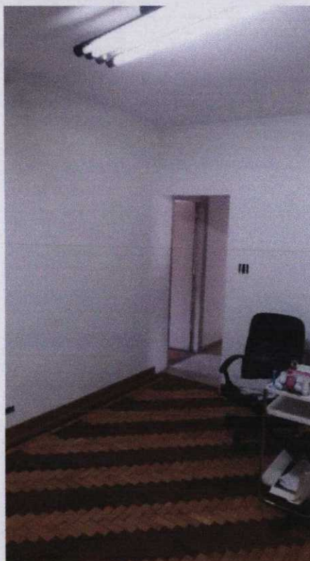
Foto 12 - Vista da sala do imóvel vistoriando.
