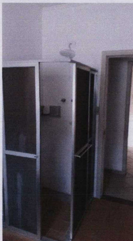
Foto 22 - Vista do banheiro social do imóvel vistoriando.
