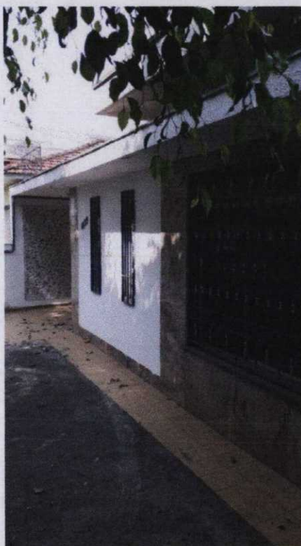
Foto 06 - Vista do quintal do imóvel vistoriando.
