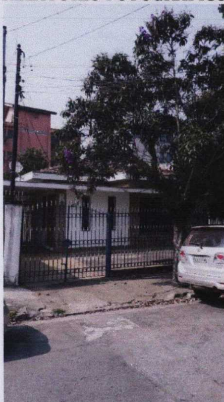
Foto 01 – Vista frontal do imóvel vistoriando.
