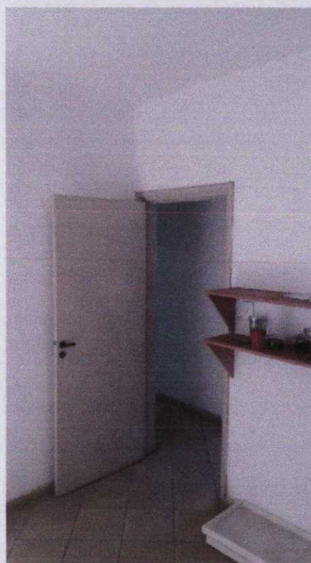
Foto 16 - Vista do segundo dormitório do imóvel vistoriando.
