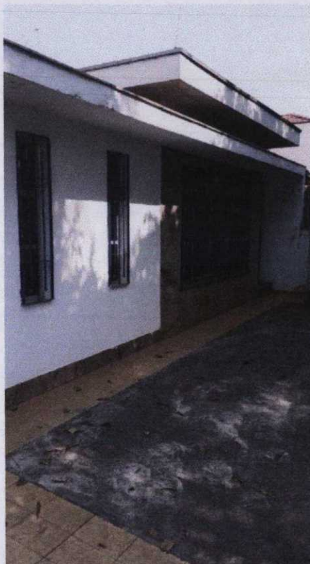
Foto 05 - Vista do quintal do imóvel vistoriando.
