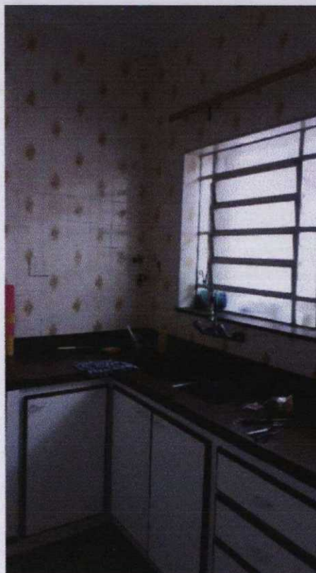
Foto 23 - Vista da cozinha do imóvel vistoriando.
