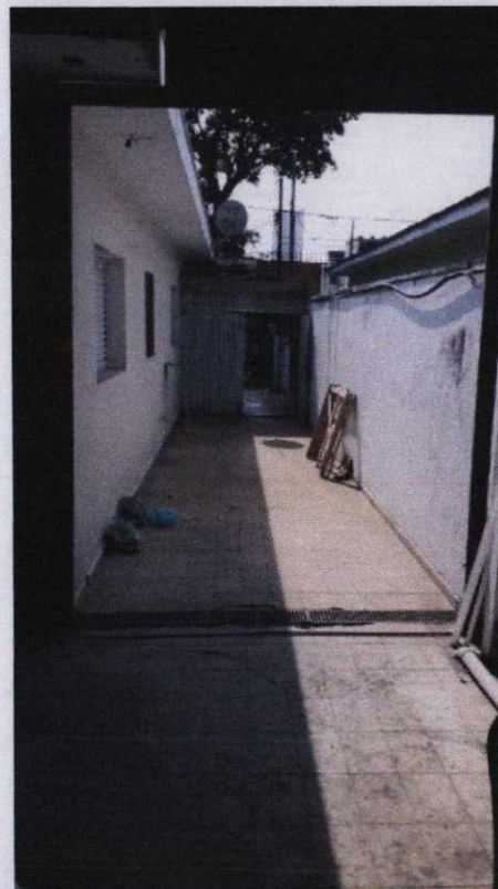
Foto 08 - Vista da garagem do imóvel vistoriando (sentido contrário).
