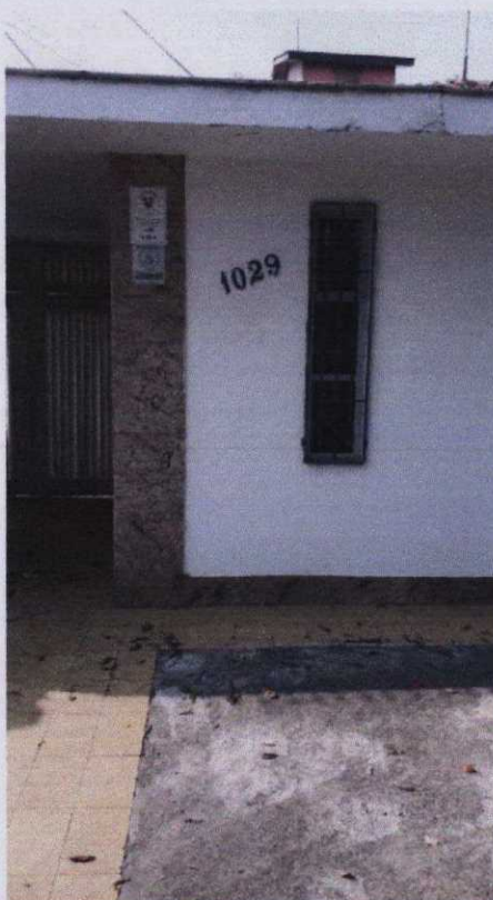
Foto 02 – Vista da identificação do imóvel vistoriando.
