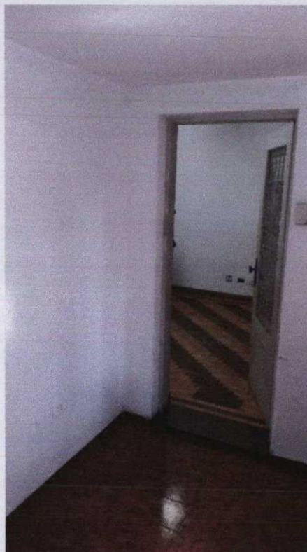
Foto 09 - Vista da antecâmara do imóvel vistoriando.
