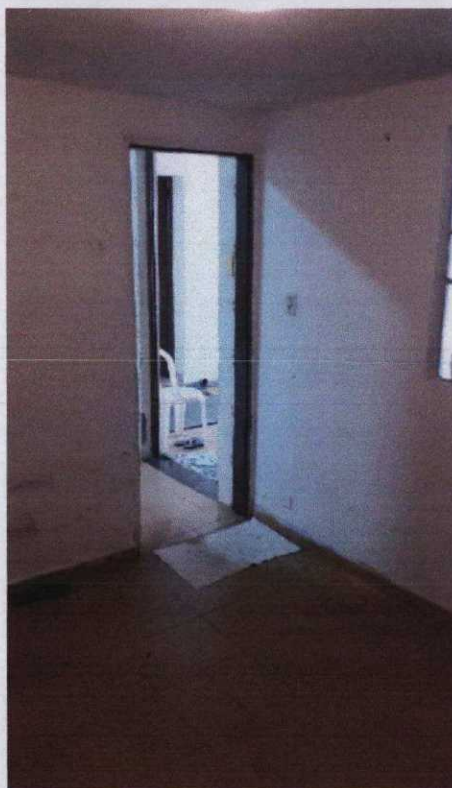
Foto 28 - Vista do primeiro cômodo da edícula do imóvel vistoriando.
