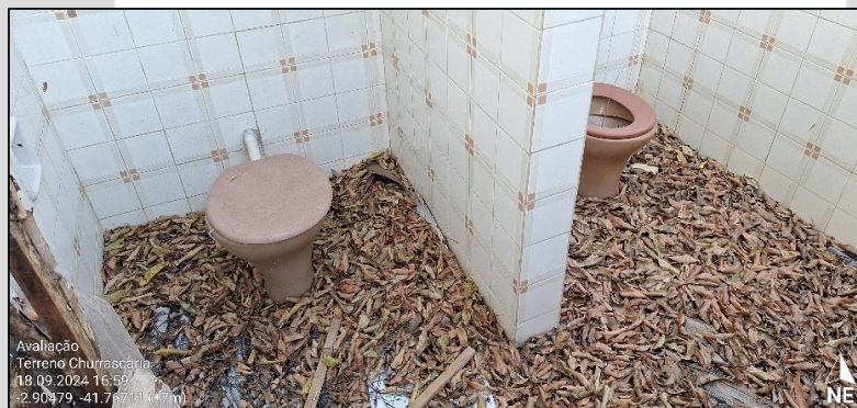
Imagem 8: Apresenta área interna do banheiro próximo da cozinha.
