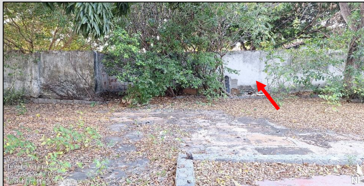
Imagem 11: Apresenta a parede NORTE no fundo do terreno avaliado.
