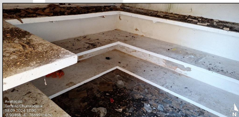
Imagem 9: Apresenta área interna do depósito próximo do banheiro.
