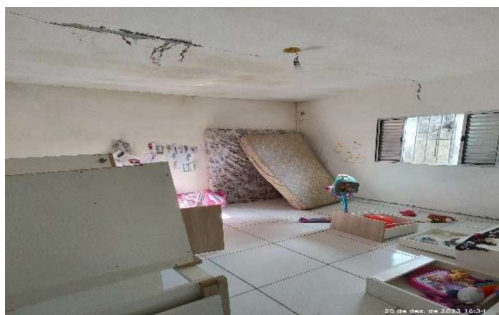
Vista dependência interna "dormitório"
