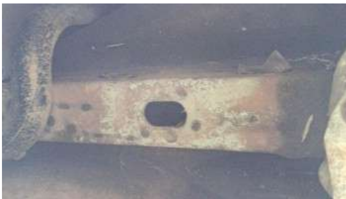
Foto Estrutura Longarina Traseira Direita
