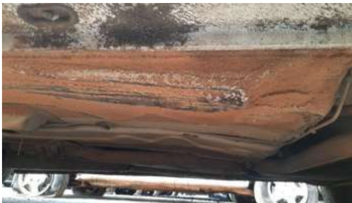
Foto Estrutura Assoalho
