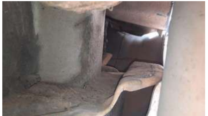
Foto Estrutura Longarina Traseira Esquerda
