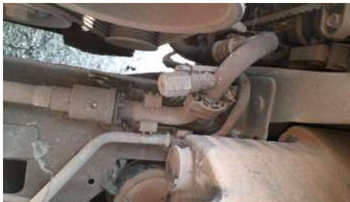
Foto Estrutura Longarina Direita
