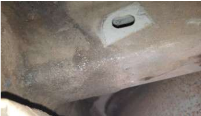
Foto Estrutura Longarina Traseira Direita
