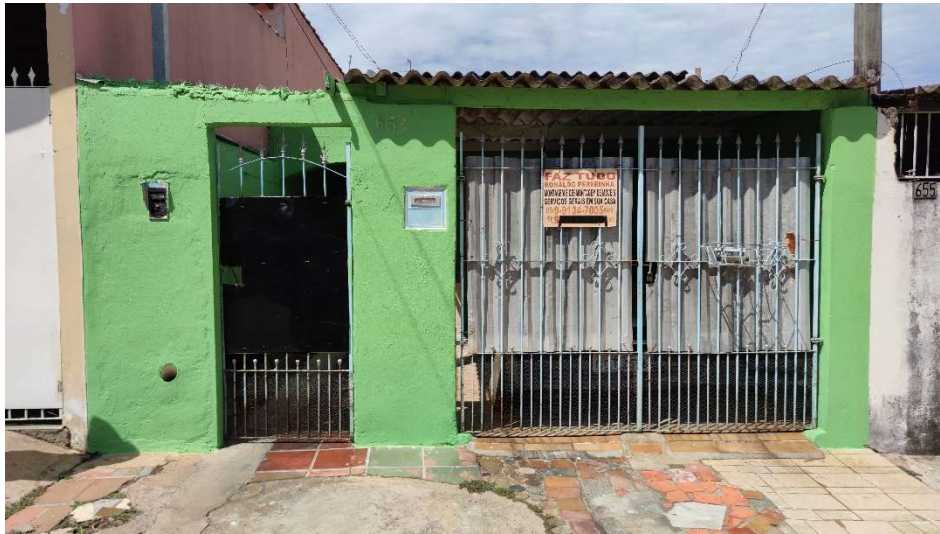
Fotografia 01 – Fachada do imóvel.
