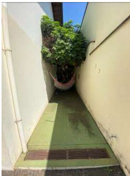
VISTA DO CORREDOR LATERAL.
