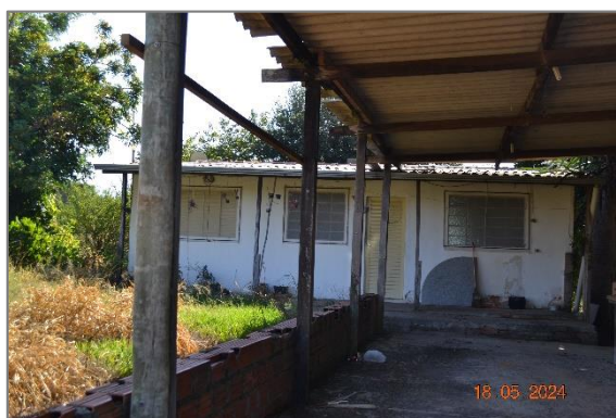
Foto 21 - Vista do Abrigo 07.
