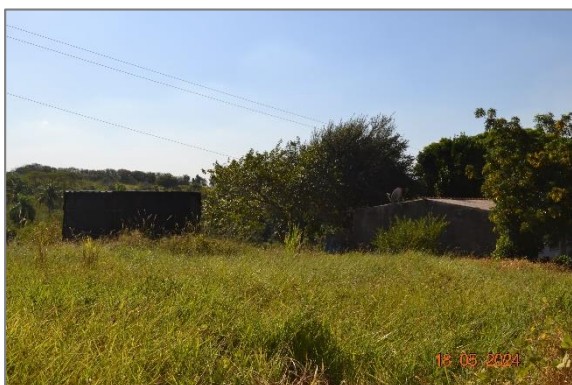
Foto 20 - Vista da casa 04 e Abrigo 07.
