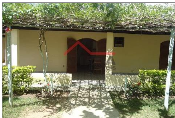
Foto 20 - Vista Acesso do Imóvel.
