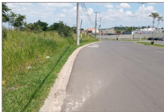
Foto 19- Vista Esquerda da Extensão.
