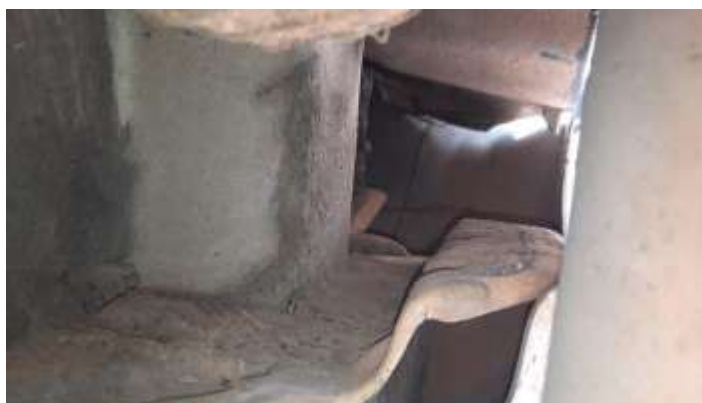
Foto Estrutura Longarina Traseira Esquerda
