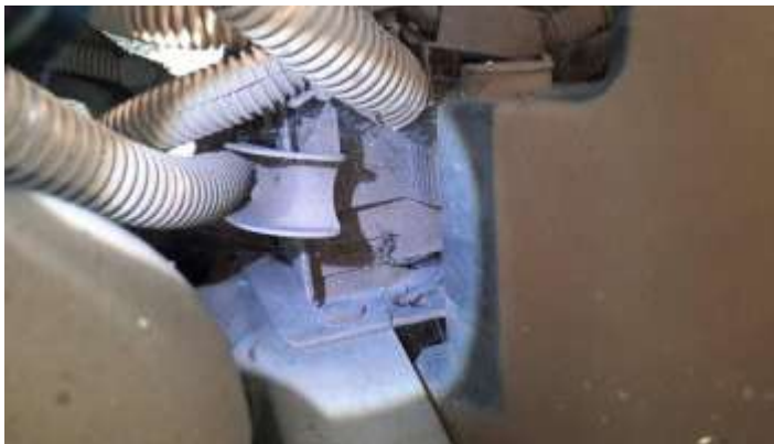
Foto Estrutura Longarina Esquerda
