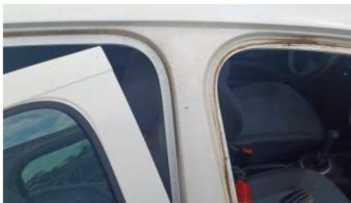
Foto Estrutura Coluna Central Direita
