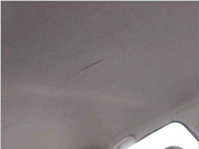
REVESTIMENTO DO TETO
