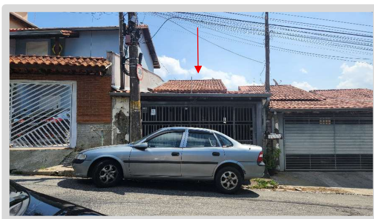
Imóvel avaliando: Rua Monte Carmelo, 132.
