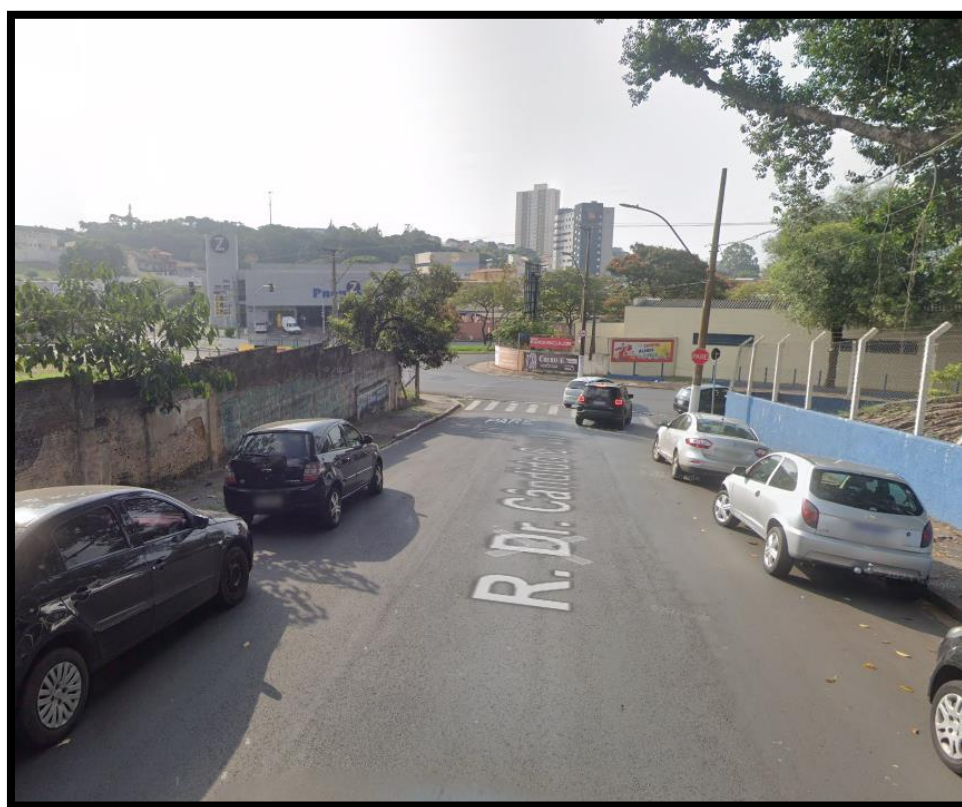
Figura 8 - infraestrutura urbana – Av. Dr Cândido Cruz
