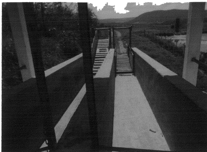
Imagem 22. Embarcador com regulagem de altura para carretas de 2 andares.
