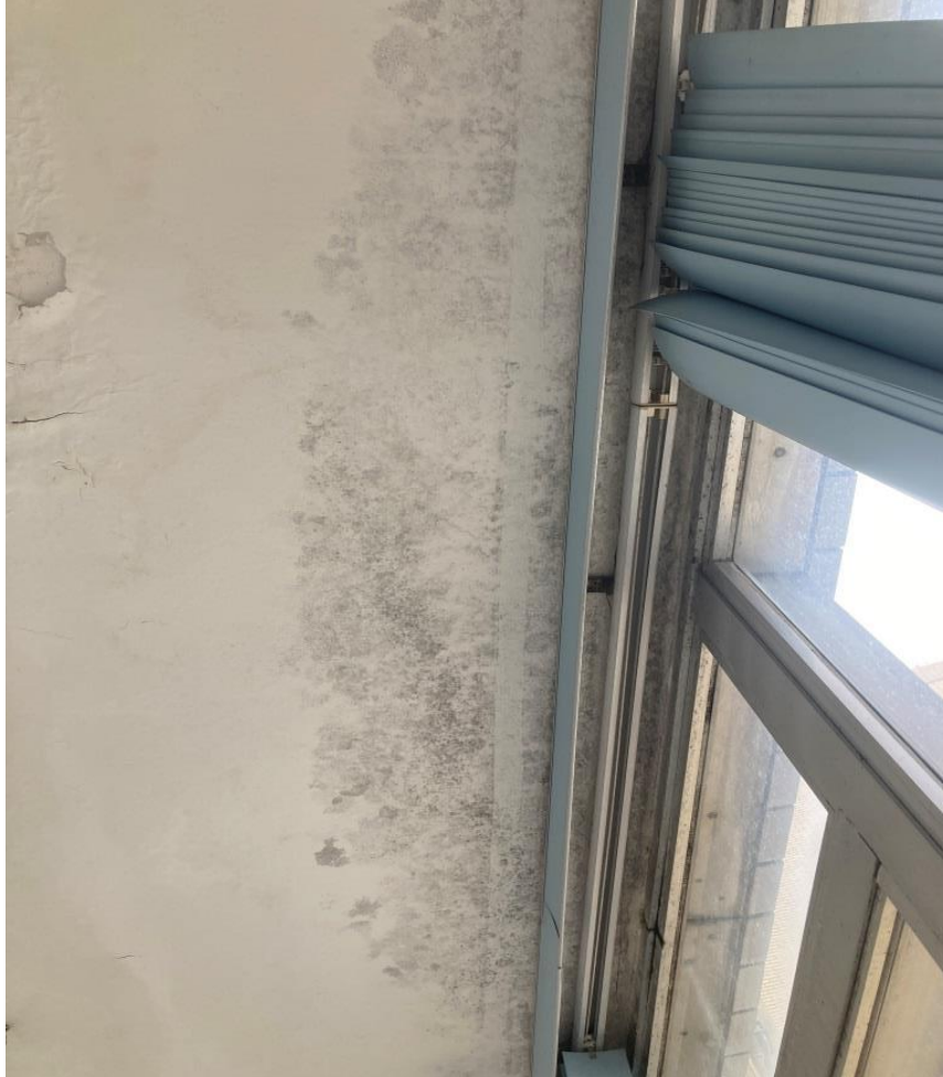
Foto 44 – Pequena infiltração no teto do terraço, oriunda da parte externa
