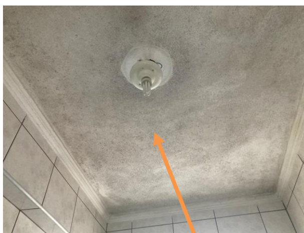
Fotos 37 e 38 – Box de vidro para espaço do chuveiro; infiltração no teto do banheiro, oriunda do apartamento sobrejacente
