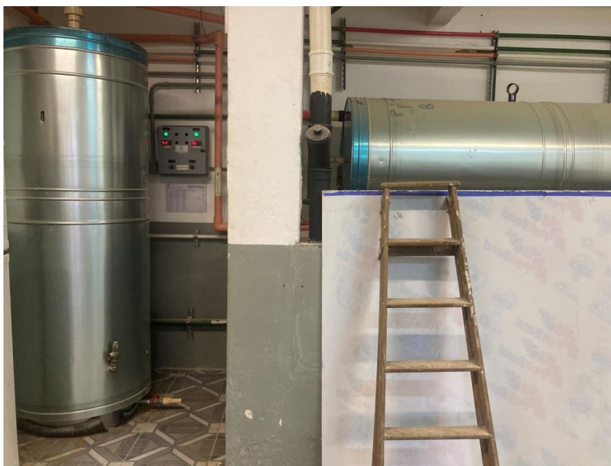
Foto 27 – Caldeira do sistema de aquecimento de água do prédio
