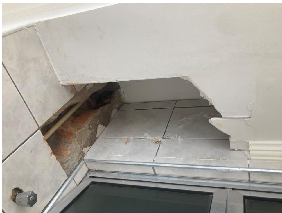
Fotos 45 e 46 – Parte do teto de gesso e parede quebrada, mostrando reparo de manutenção hidráulica não terminada na área de serviço
