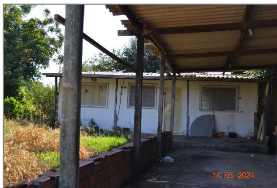
Foto 21 - Vista do Abrigo 07.
