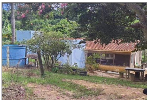
Foto 10 - Vista as Construções Casas.
