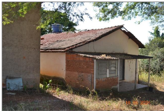
Foto 25- Vista externa da casa 03.
