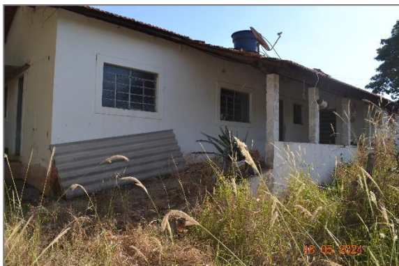
Foto 28 - Vista Externa casa 02.
