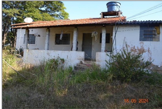
Foto 29 - Fachada entrada Área da casa 02.
