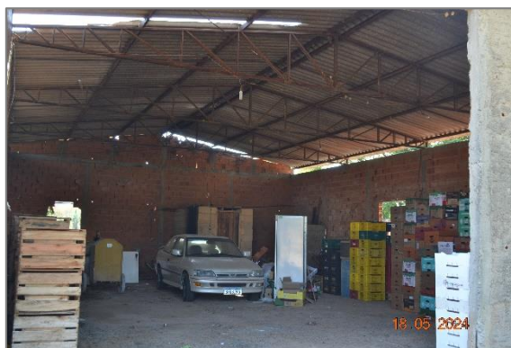
Foto 23 - Vista interna do Deposito.
