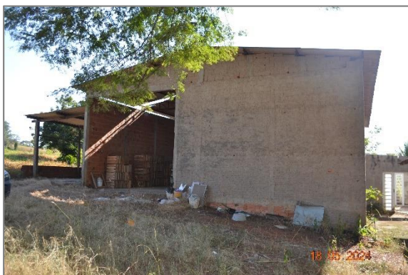
Foto 24 - Vista entrada do Depósito 05.
