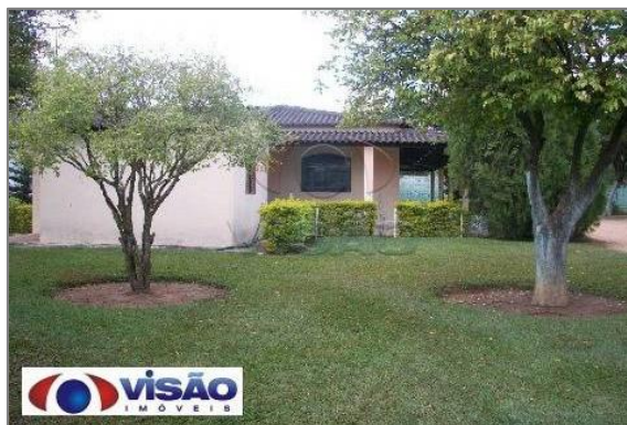
Foto 22 - Vista a entrada do Imóvel.
