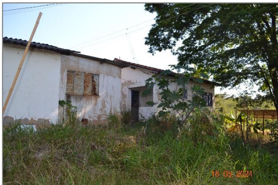
Foto 30 - Vista entre Casa 02 e 01.
