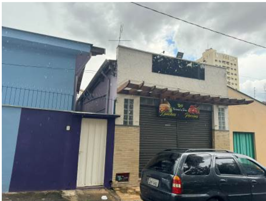
VISTA DA FACHADA DO IMÓVEL – TRAVESSA MARIA MOSNA VITTI.
