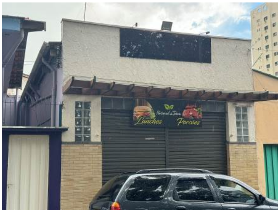
VISTA DA ENTRADA DO IMÓVEL.
