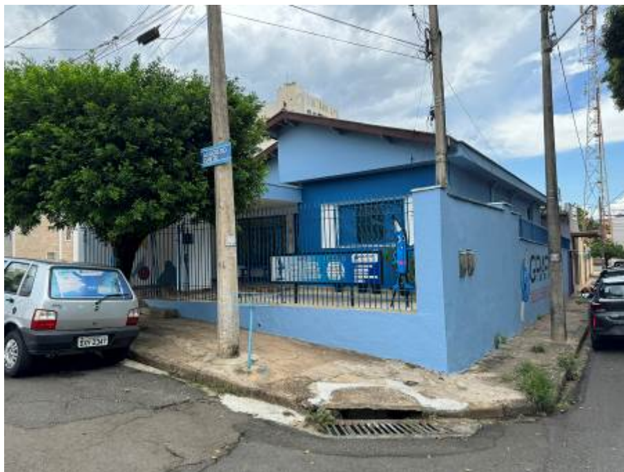
VISTA DA FACHADA DO IMÓVEL – RUA ACÁCIO DO CANTO.
