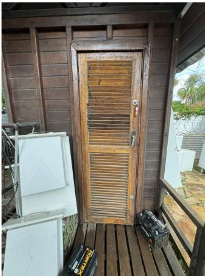
VISTA DO DEPÓSITO.
