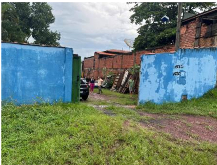
VISTA DA ENTRADA DO IMÓVEL.
