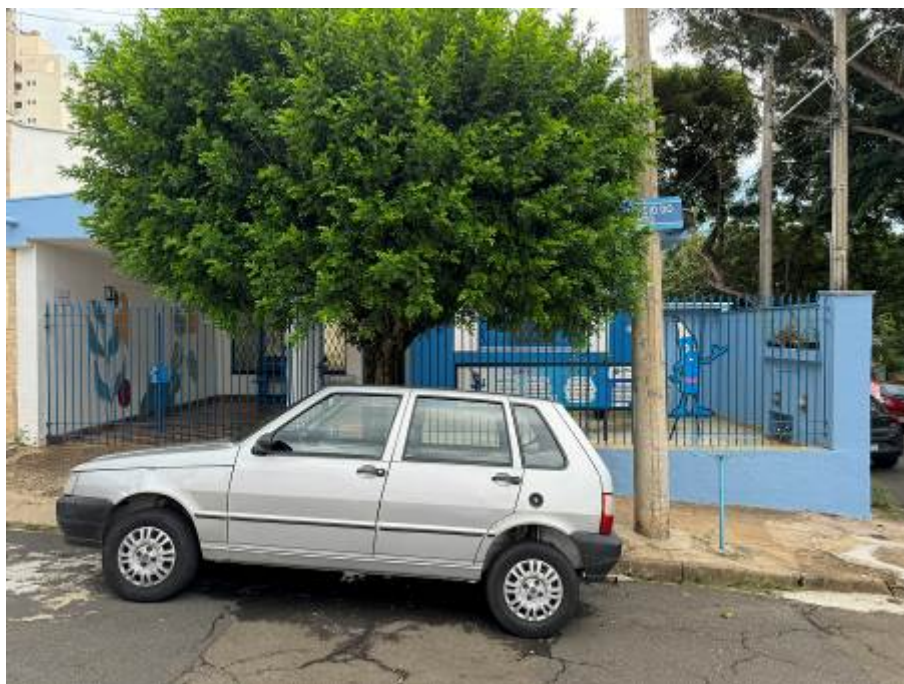
VISTA DA ENTRADA DO IMÓVEL.
