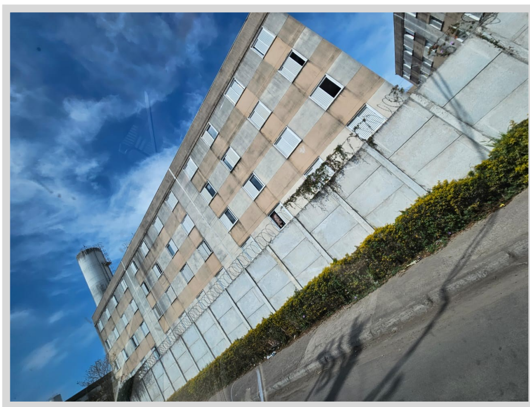
Condomínio Residencial Jundiapéba I, classificado como: Edifício residencial, Grupo 1. 3 – Apartamento, 1.3.1-Padrão Econômico.
