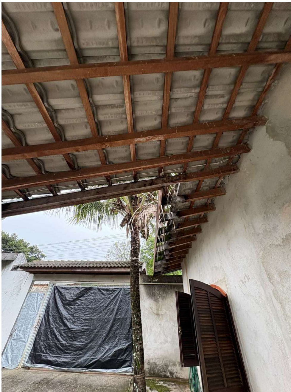
Figura 8: varanda - cobertura em telha
