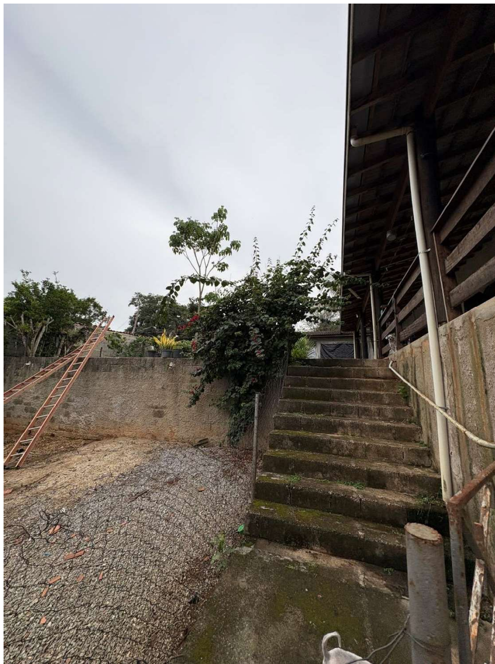
Figura 44: escada de acesso à varanda
