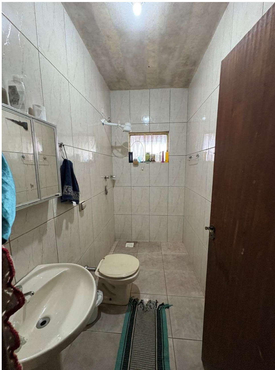
Figura 13: banheiro – piso e paredes em cerâmica simples
