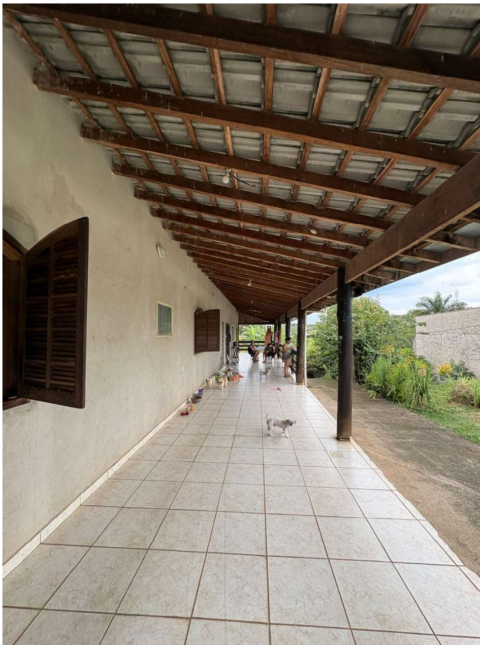
Figura 9: varanda - piso em cerâmica simples
