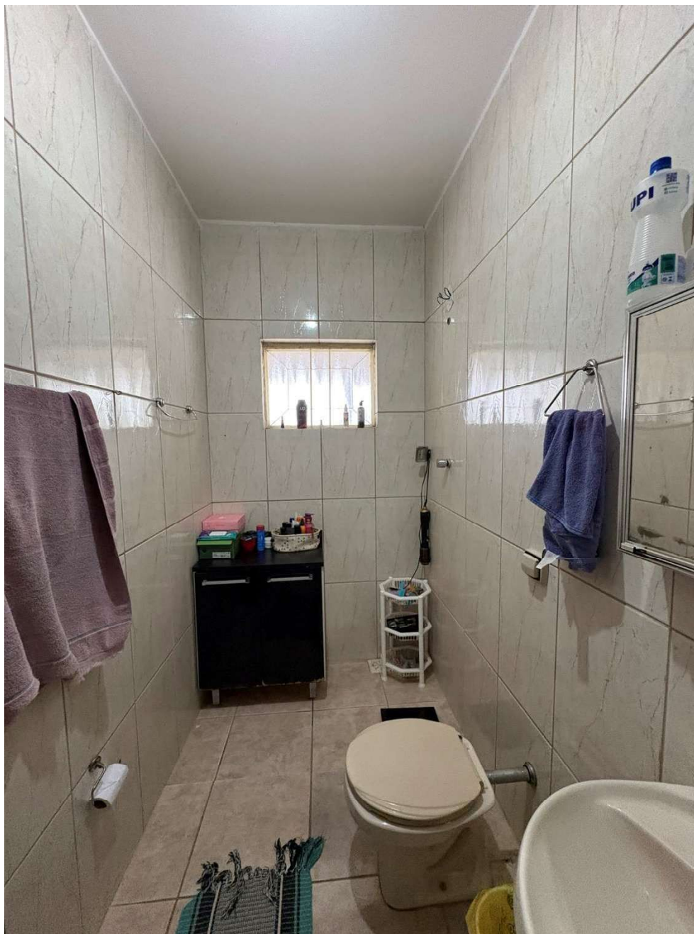
Figura 18: banheiro – piso e paredes em cerâmica simples
