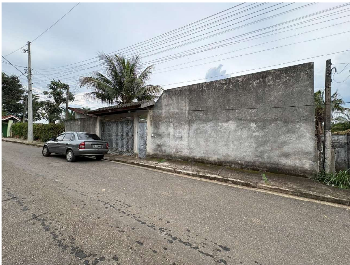
Figura 1: Fachada do Imóvel Avaliando
