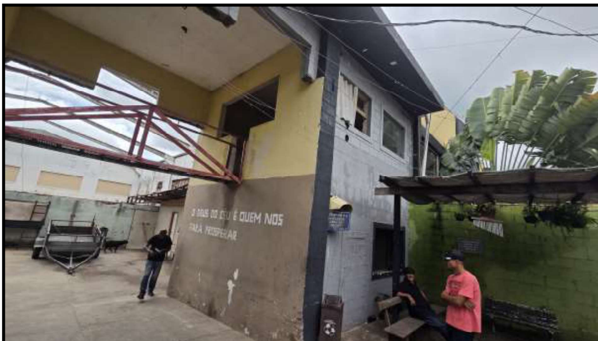
23. Vista da frente do galpão.
