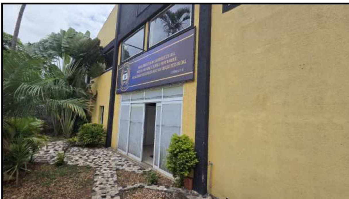
2. Fachada do galpão (nº 45).
