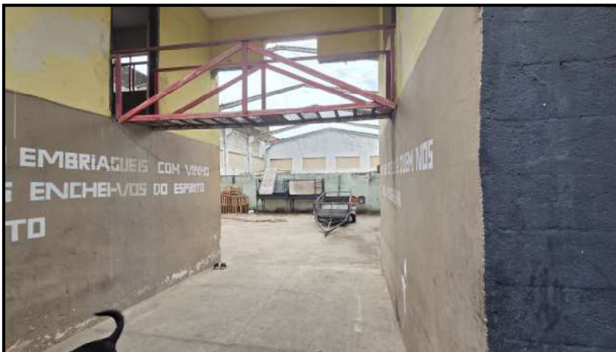
25. Frente e acesso ao interior do galpão.
