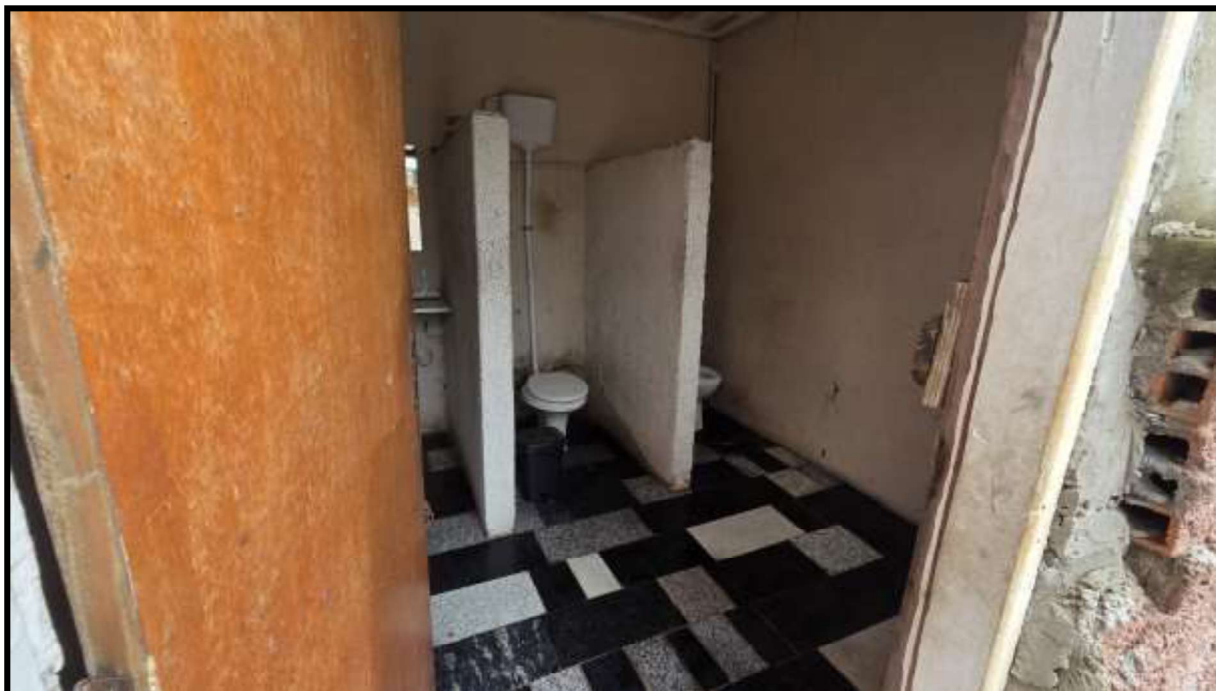
33. Vista interna dos banheiros.
