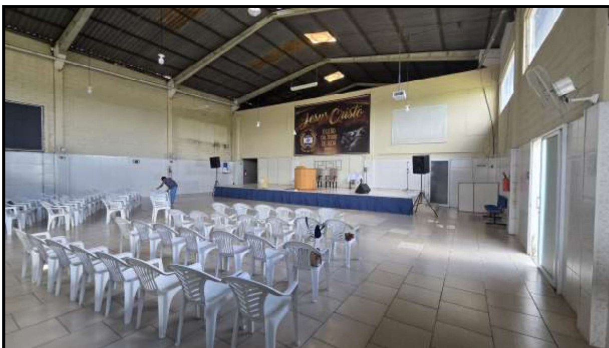
6. Vista interna do salão (pavimento térreo).
