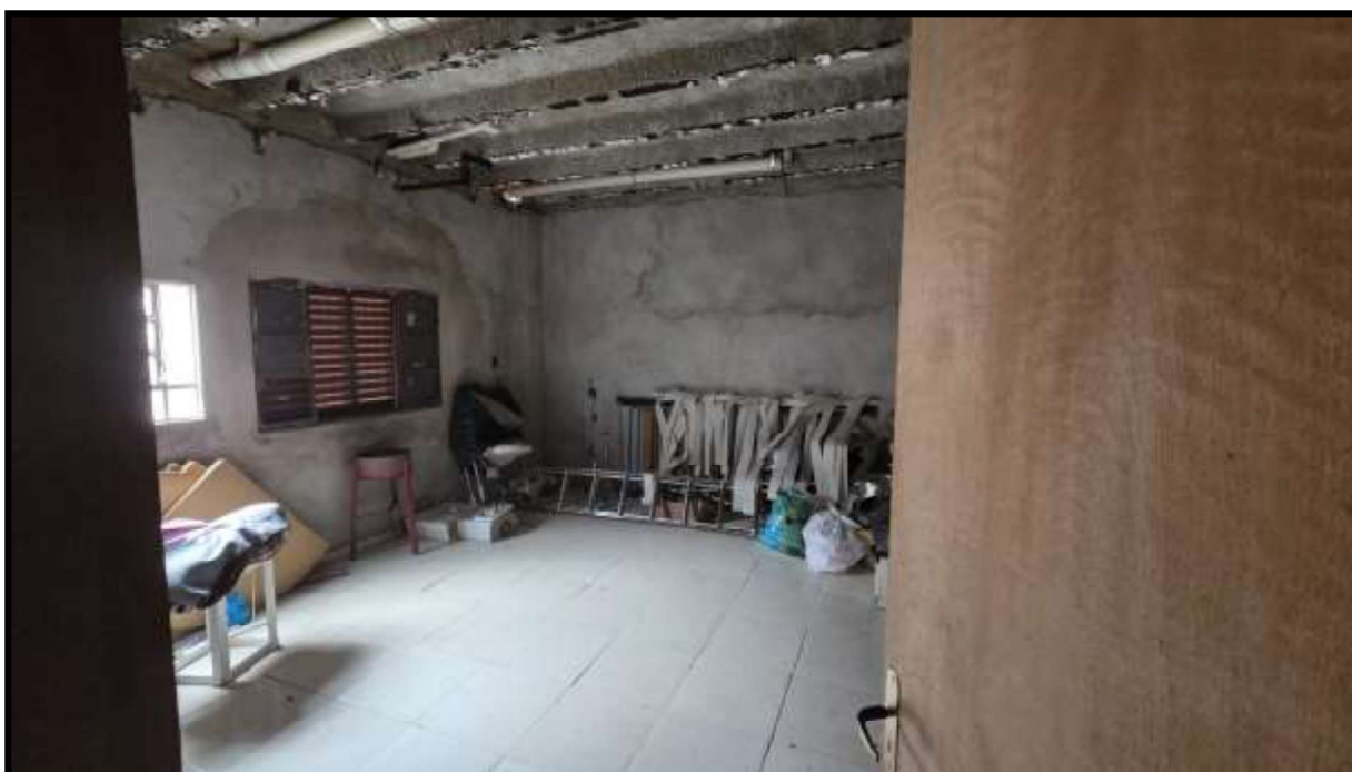
10. Vista de outra sala.
