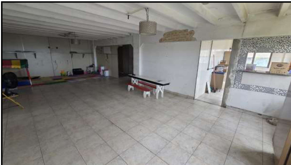
17. Pavimento superior. Vista interna do salão.
