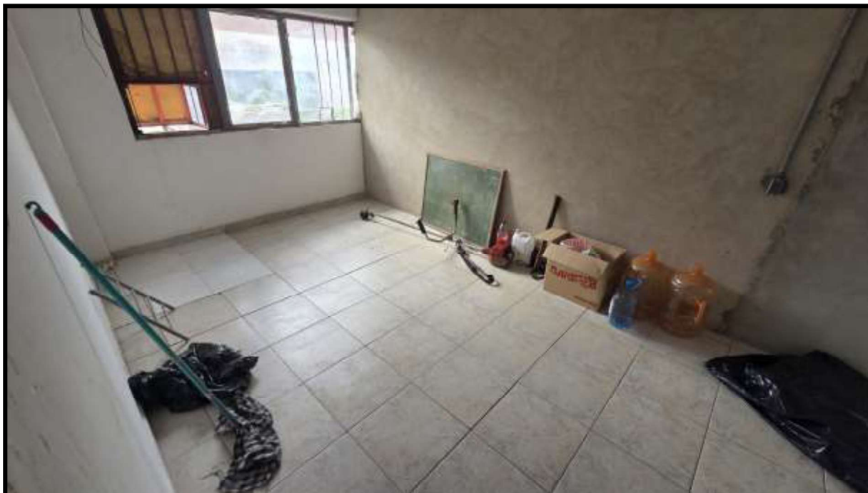
21. Pavimento superior. Vista interna de uma das salas.
