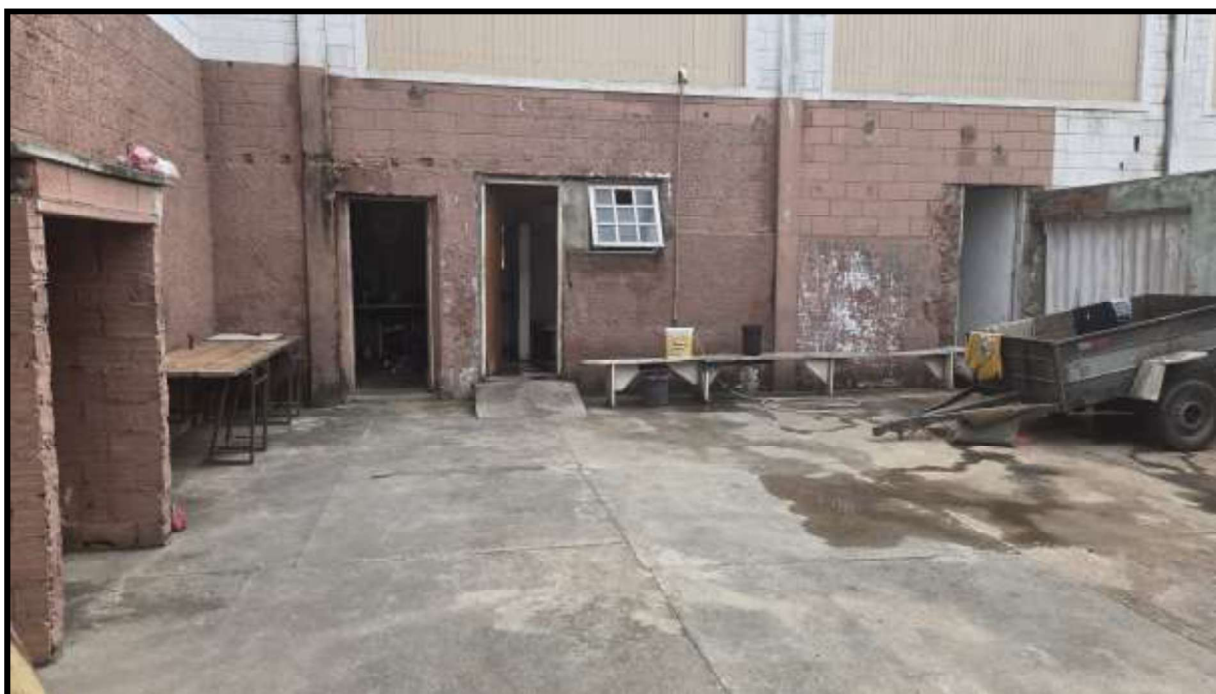
30. Parte dos banheiros.
