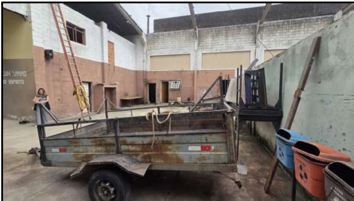
27. Vista do galpão sem a cobertura e parte da frente com o mezanino.
