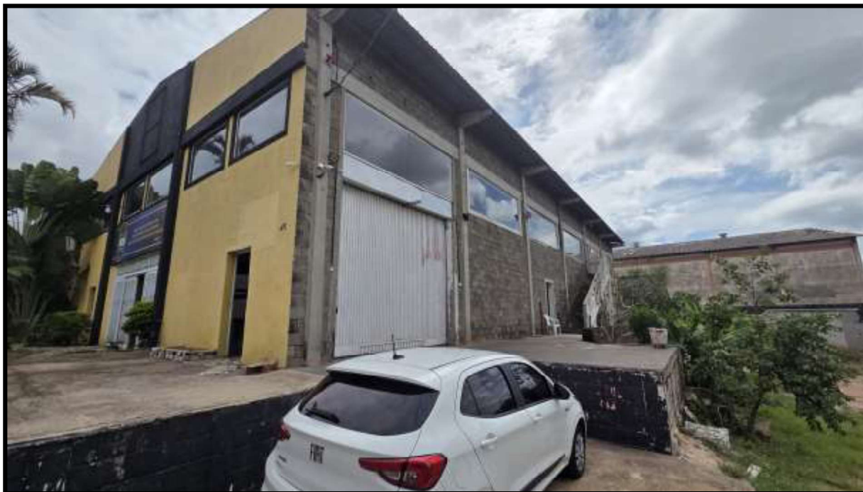
3. Fachadas lateral e frontal do galpão (nº 45).
