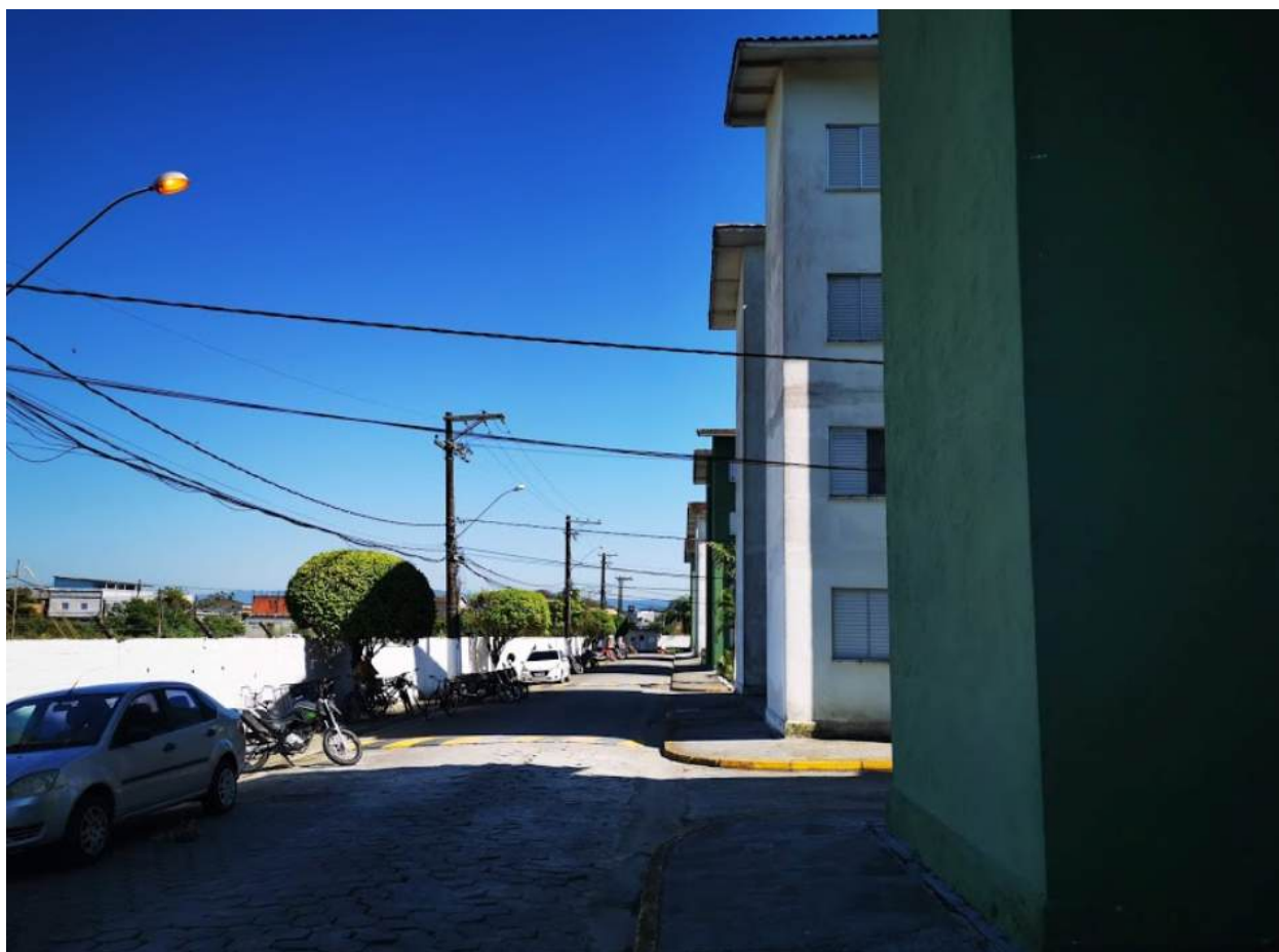
FOTO 01 - Rua interna do Condomínio Residencial Jardim Bela Vida I
