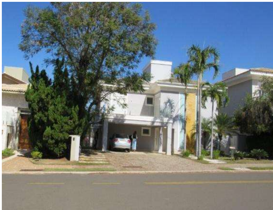
Foto 2 – Vista da fachada do imóvel avaliando.
