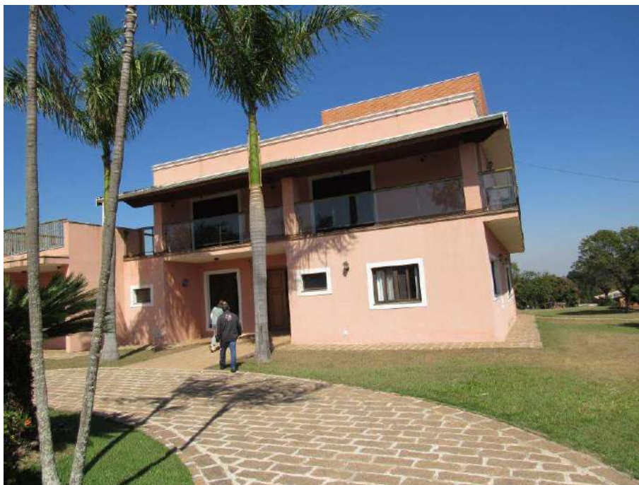
Foto 13 – Fachada do imóvel avaliando.
