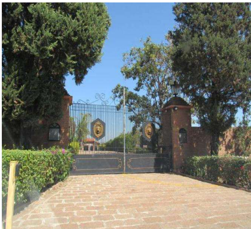
Foto 12 – Entrada do imóvel avaliando.
