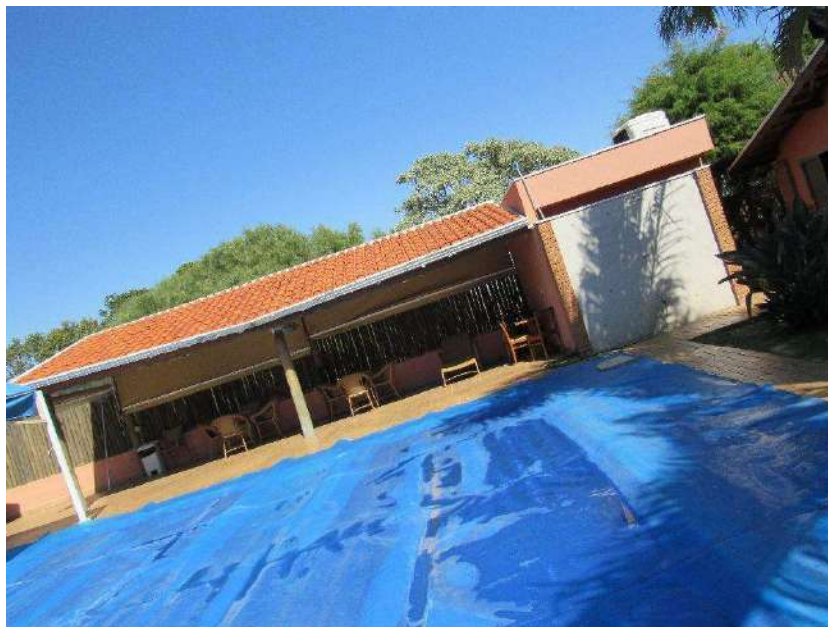
Foto 74 – Quiosque da piscina
