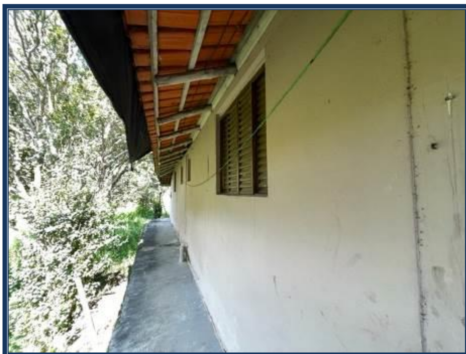
Vista externa da edificação 02.
