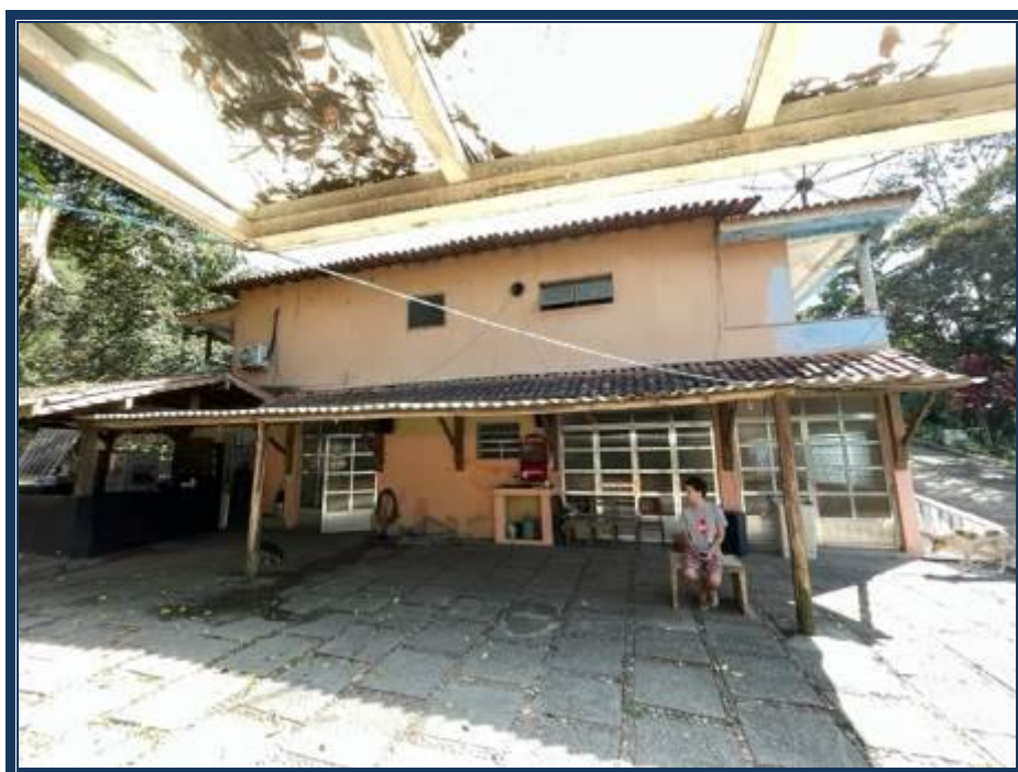
Vista externa da edificação 01.
