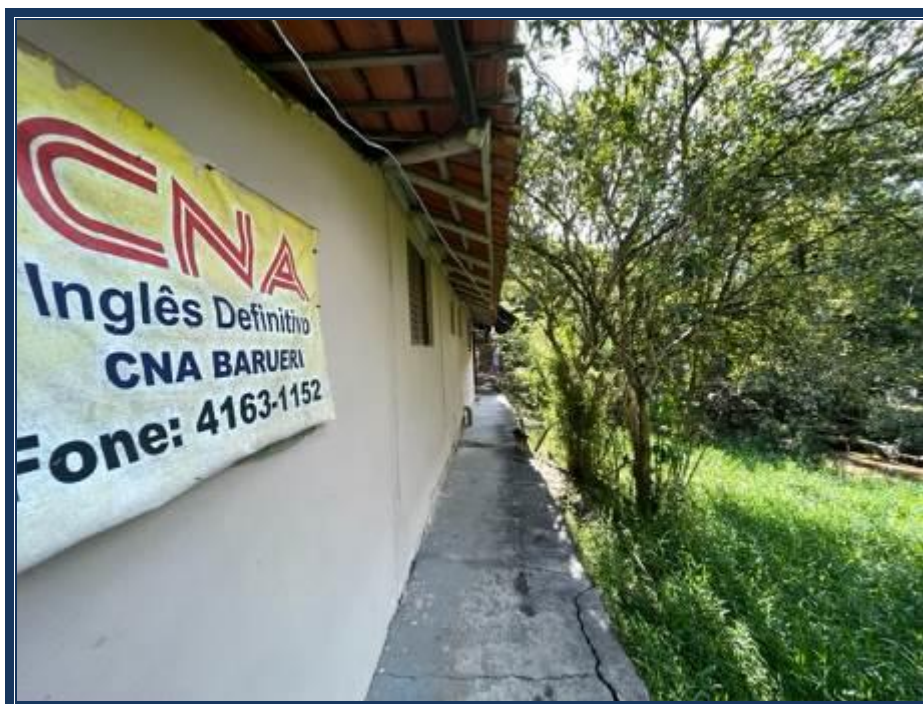
Vista externa da edificação 02.
