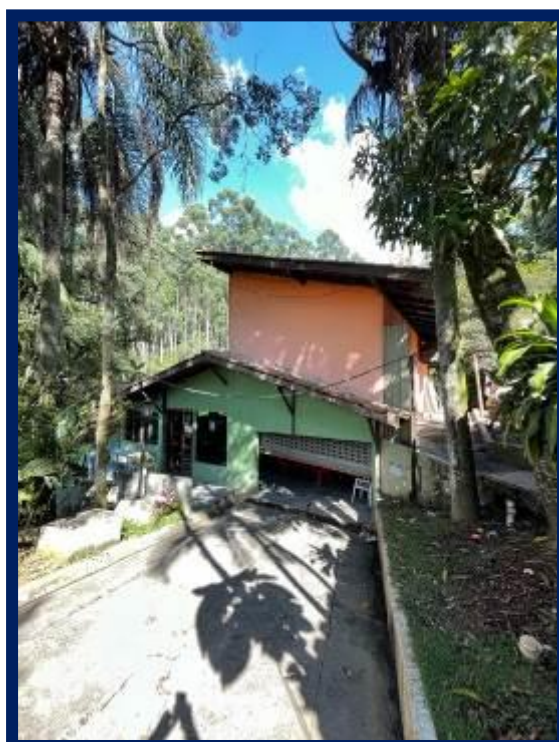
Vista externa da edificação 03.
