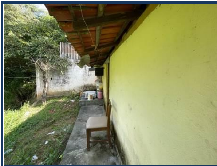
Vista externa da edificação 02.
