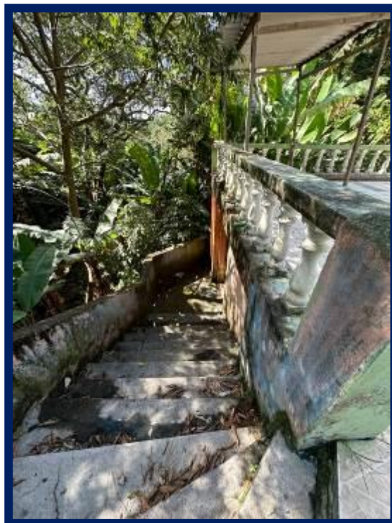
Vista externa da edificação 04.
