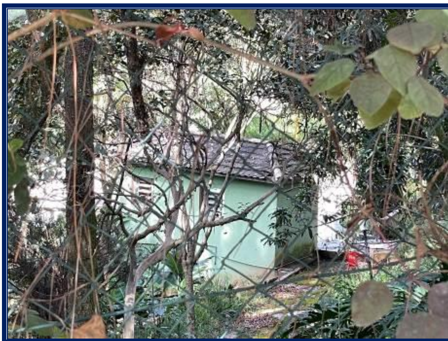
Vista externa da edificação 02.
