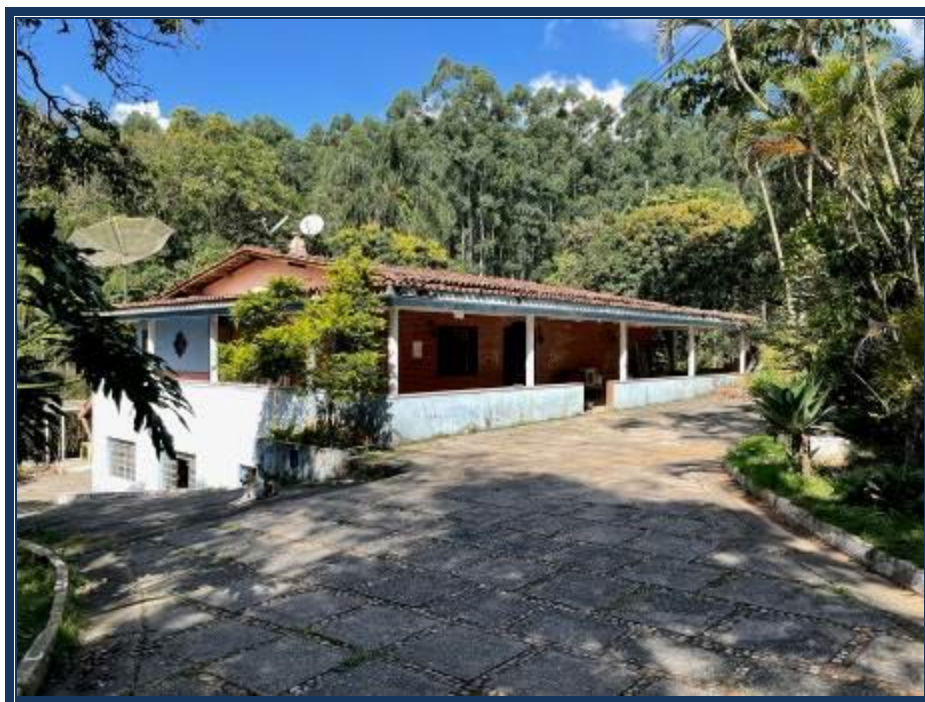
Vista externa da edificação 01.
