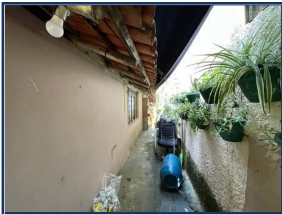
Vista externa da edificação 02.
