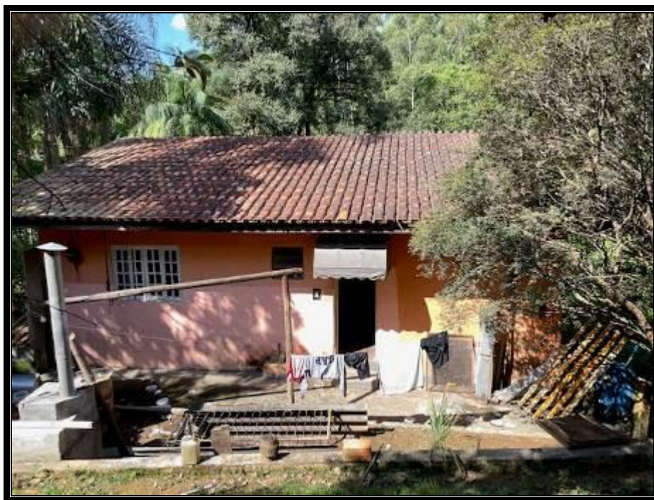
Vista externa da edificação 03.
