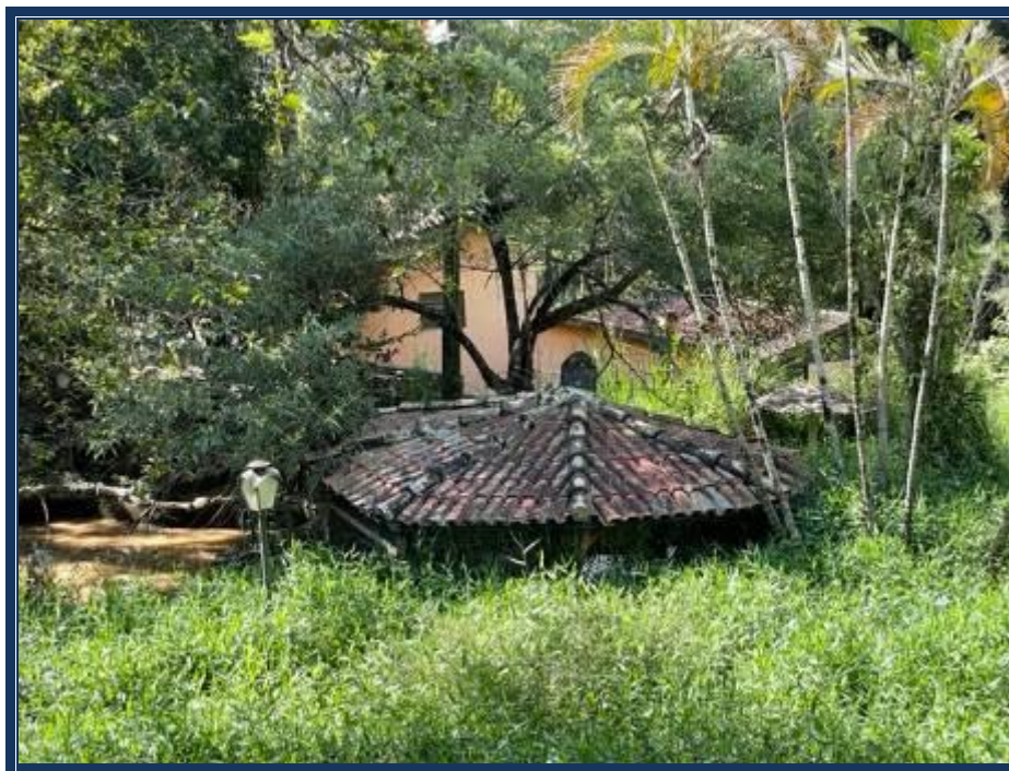
Vista externa da edificação 01.
