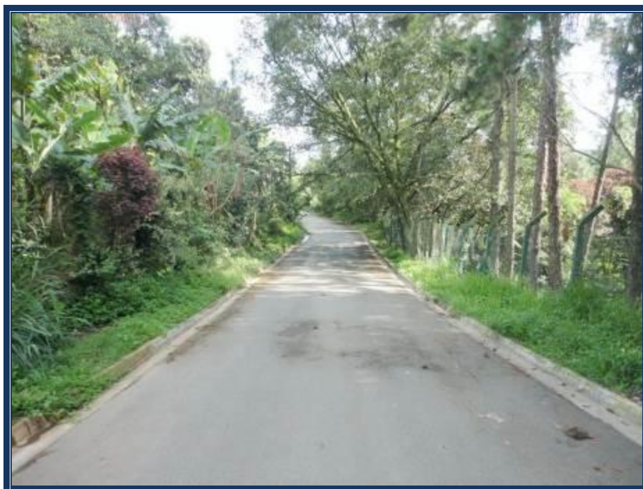
Vista da Rua Zeus que lhe dá acesso.
