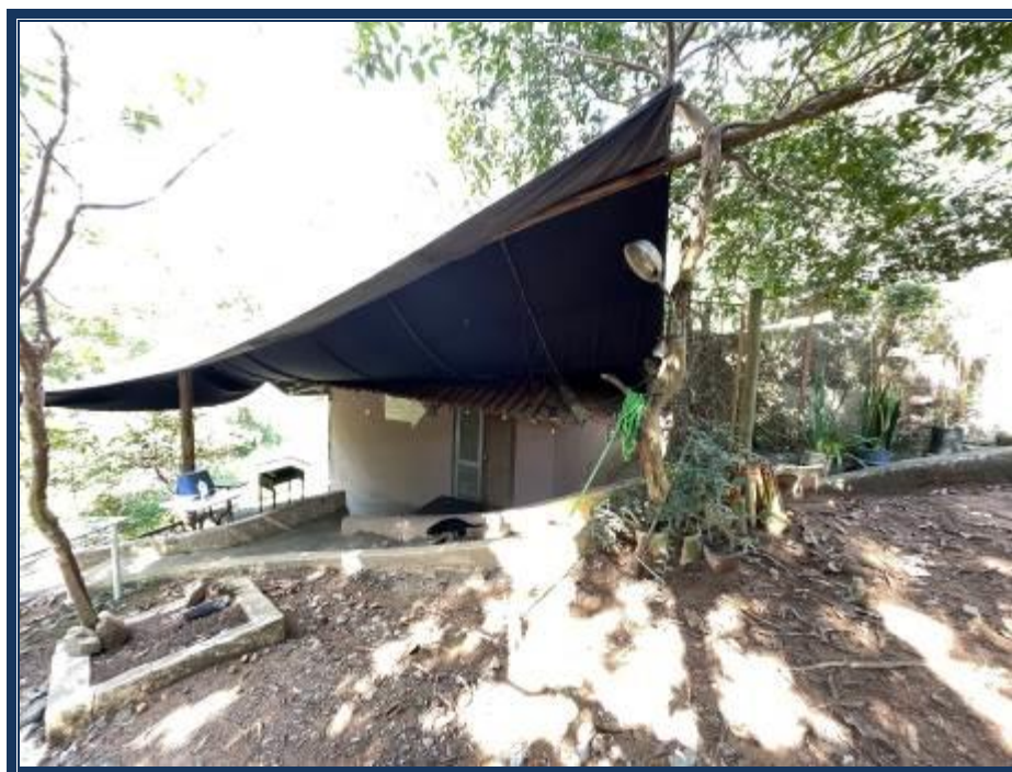
Vista externa da edificação 01.
