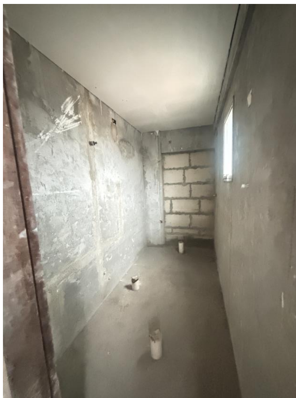
Figura 13: Banheiro da suíte 2.
