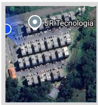
Vista aérea do Condomínio Residencial Apoema II.
