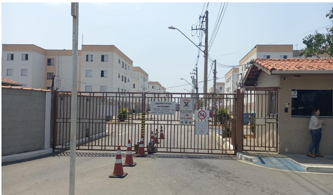
Foto 02. Vista do acesso ao Condomínio Jacarandá
