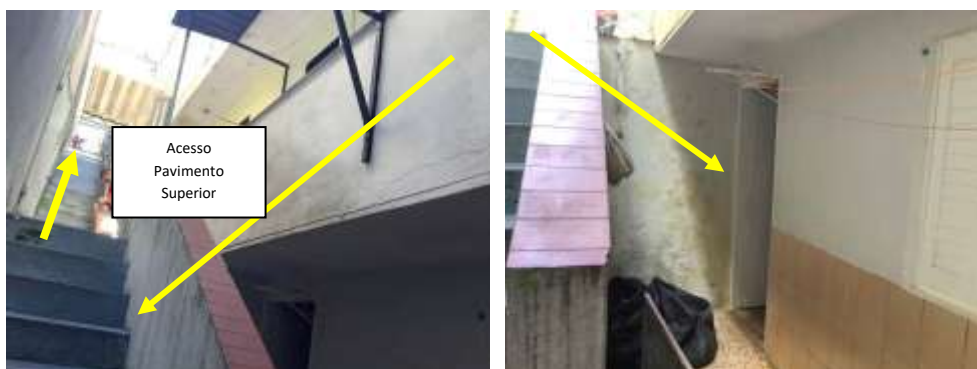
Vista do acesso ao subsolo com escada e depósito ao lado.
