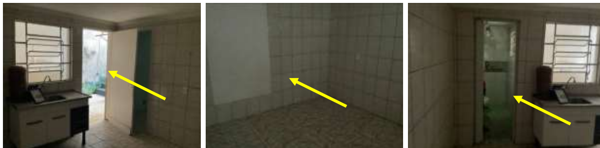
Vista da área de cozinha – porta de entrada, interno e acesso banheiro social.
