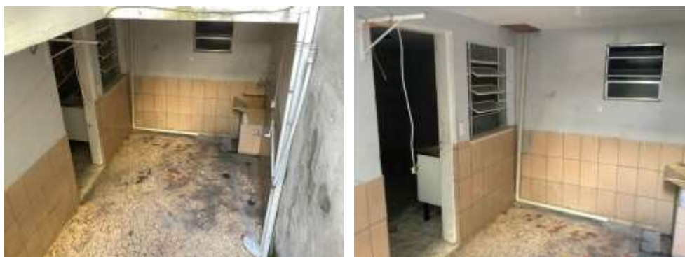
Vista do acesso área de serviço e porta de acesso ao pavimento subsolo.
