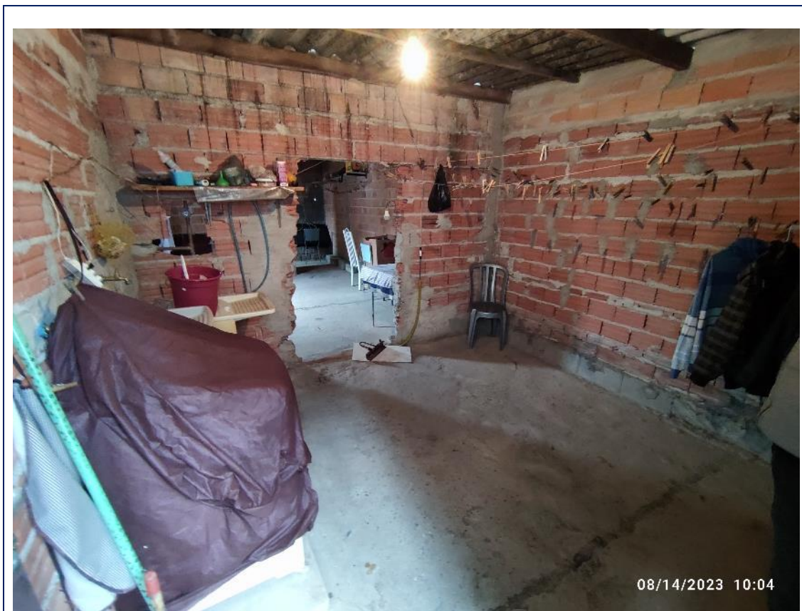
Foto 15 – Vista da obra do terceiro pavimento.
