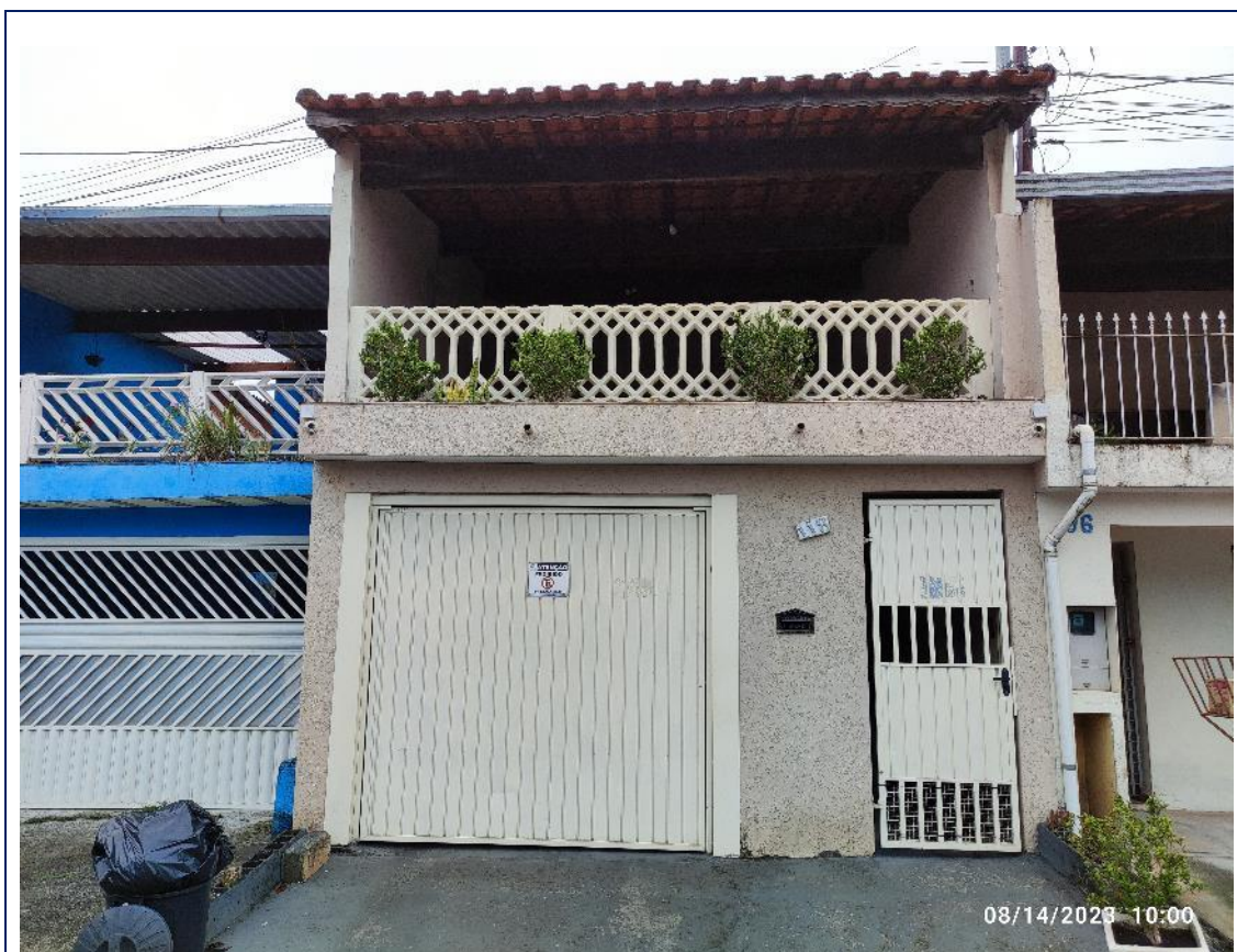
Foto 3 – Vista da fachada frontal do imóvel avaliando, localizado na Rua Jaguari, nº 118 - Tanque Caio, Ribeirão Pires - SP.
