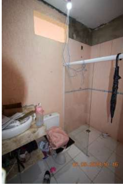
Banheiro do dormitório 2.
