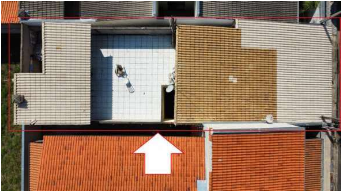
Vista do telhado, solarium e espaço “gourmet”.
