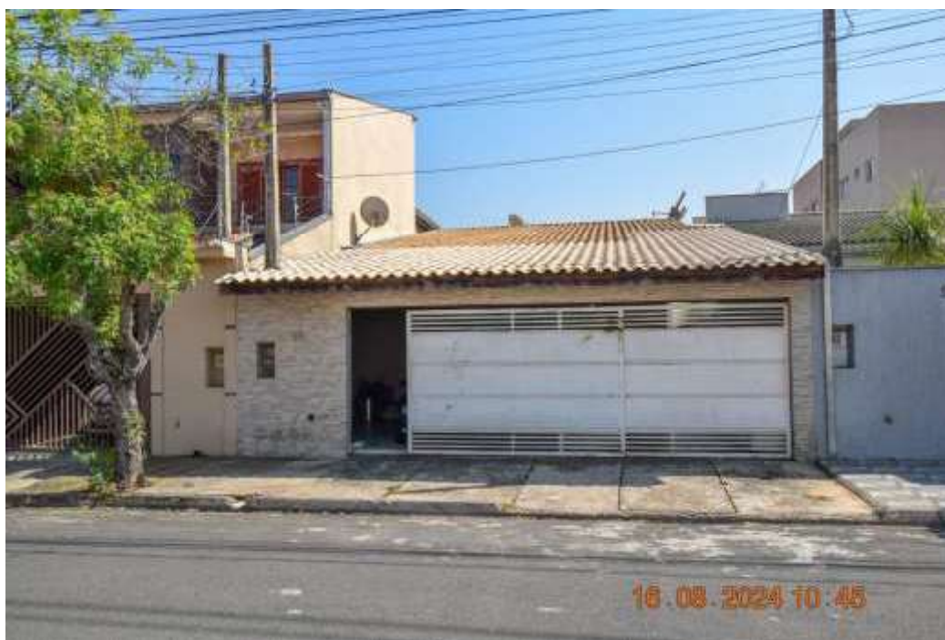
Vista do Imóvel Avaliando
