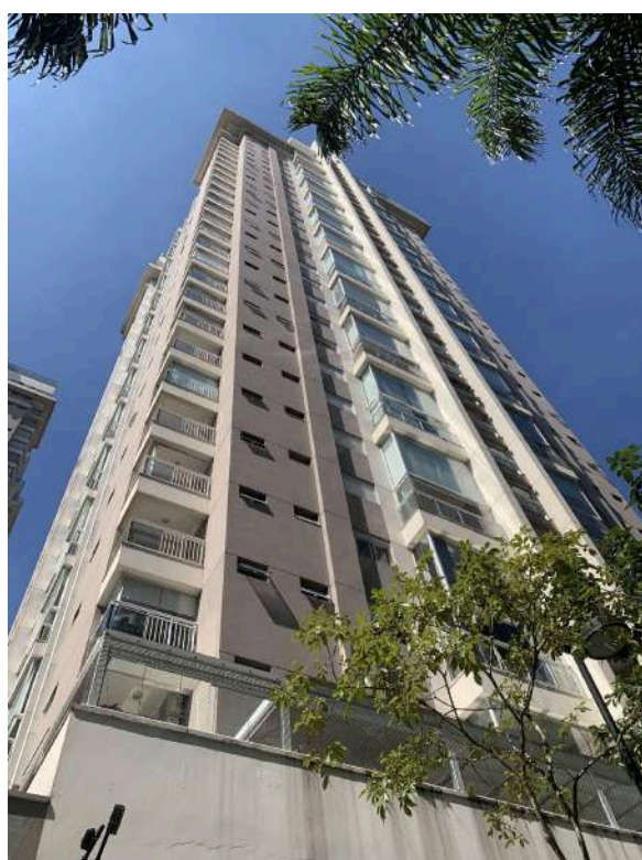
Figura 2 – Fachada do prédio
