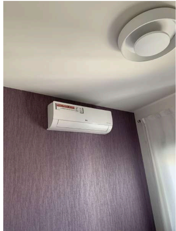
Figura 45 – Vista do quarto 02
