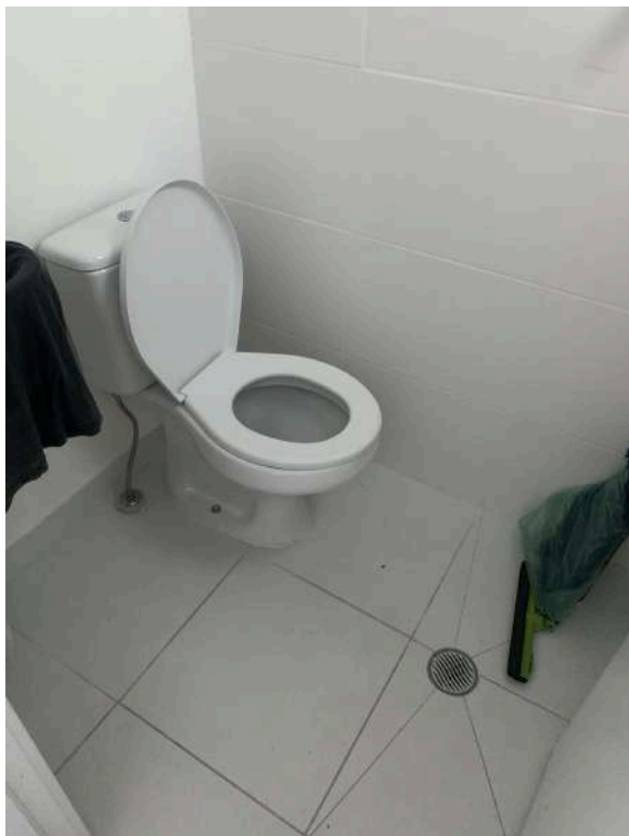
Figura 10 – Vista da área de serviço - Banheiro
