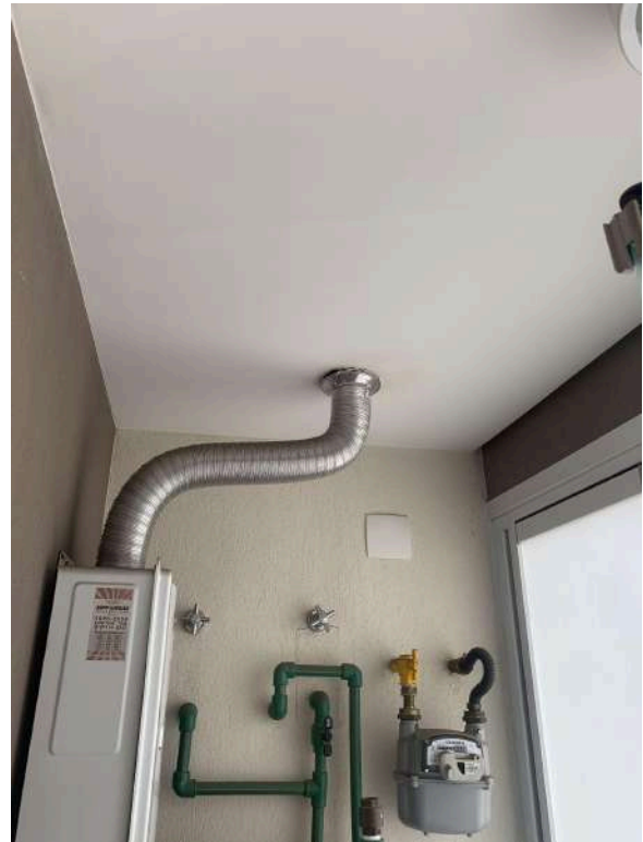
Figura 13 – Vista da área de serviço
