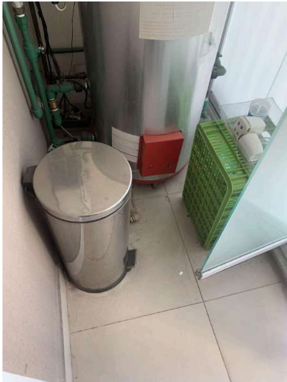
Figura 12 – Vista da área de serviço
