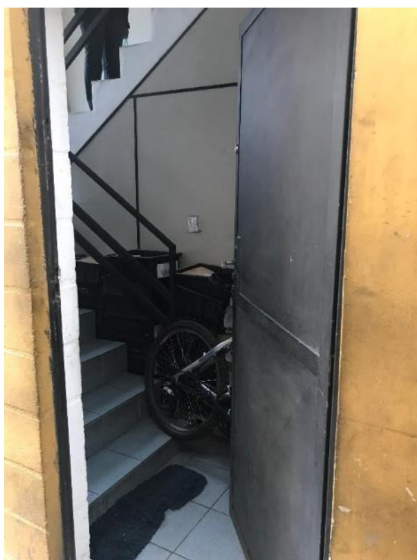
Foto 43: Escadaria de acesso ao pavimento térreo.
