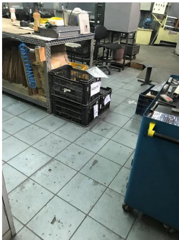
Foto 46: Salão de produção no pavimento térreo.
