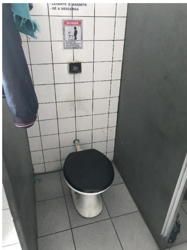
Foto 30: Vestiário do banheiro do primeiro pavimento.
