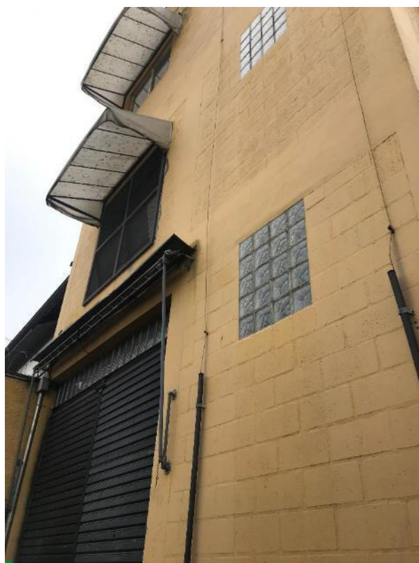
Foto 6: Vista da fachada frontal – pavimento térreo e superiores.
