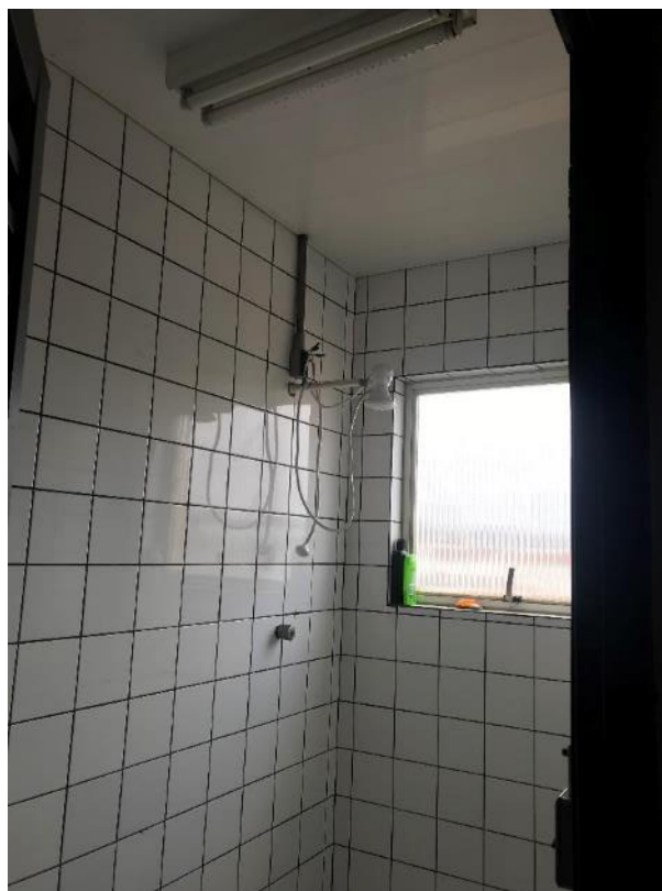
Foto 14: Banheiro do segundo pavimento.
