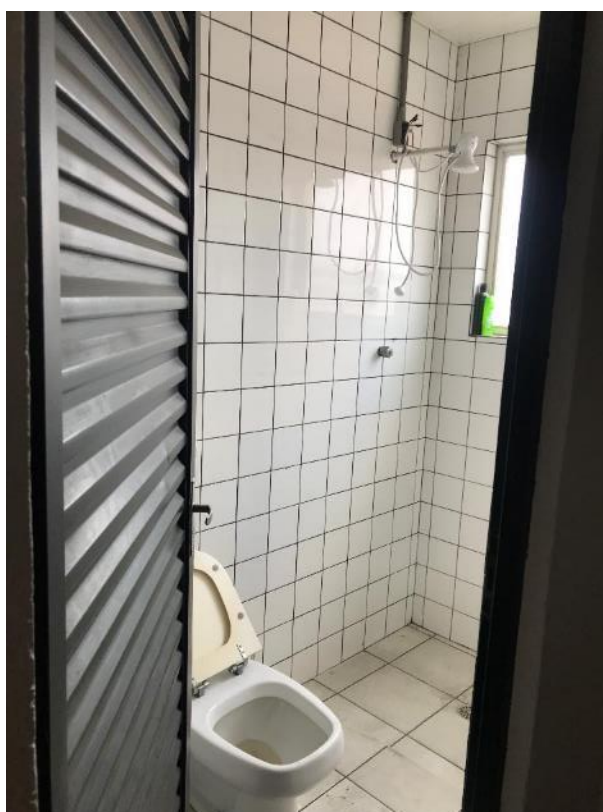
Foto 13: Banheiro do segundo pavimento.
