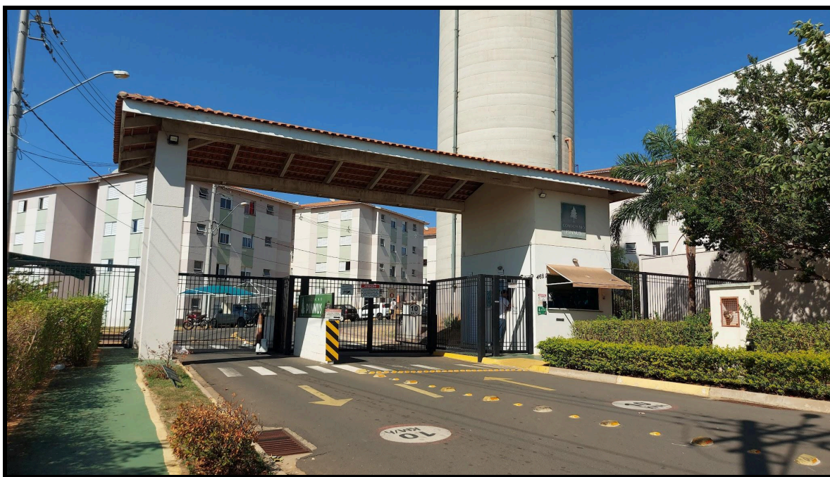
Condomínio Residencial Pinnus - Indaiatuba/SP
