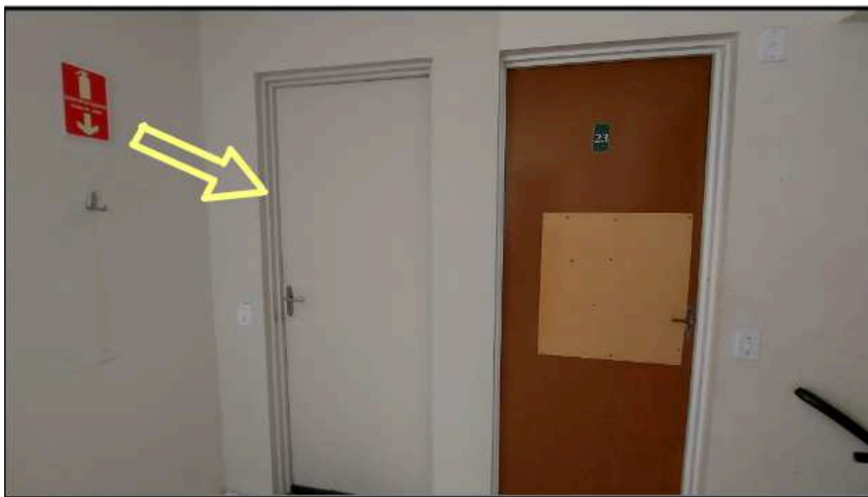
Apto 24 Bloco 04 - Condomínio Residencial Pinnus - Indaiatuba/SP
