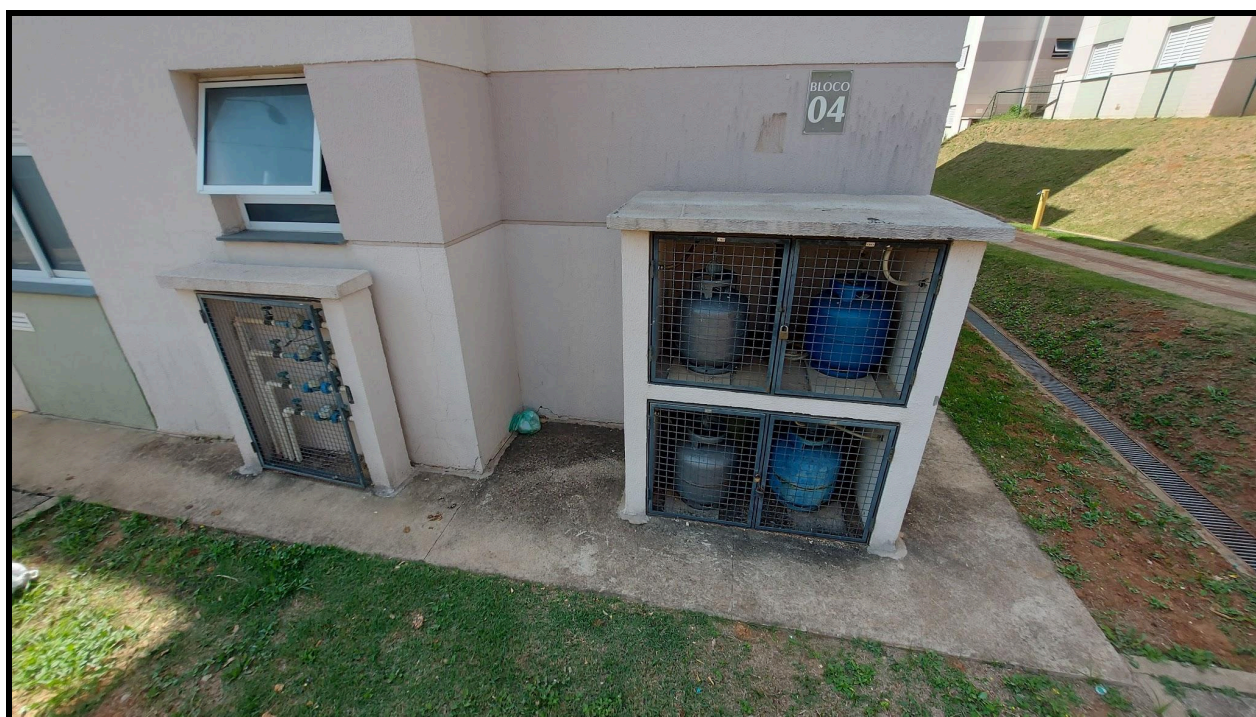
Relógio de água e botijão de gás individualizados - Cond. Resid. Pinnus
