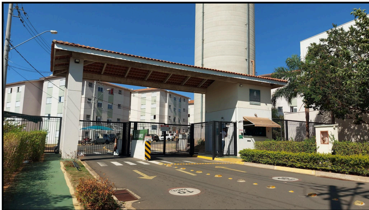
Condomínio Residencial Pinnus - Indaiatuba/SP
