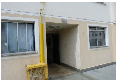
acesso ao bloco 10
