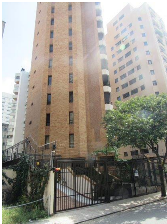
Foto 1 – Fachada do Edifício
