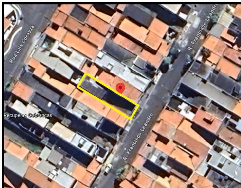
Vista Aérea - Rua Francisco Leandro, 131, - Americana/SP
