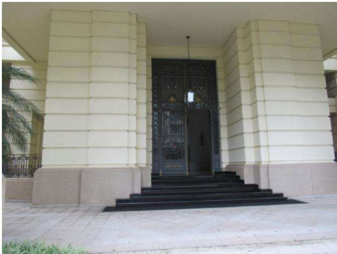
Foto 6 – Entrada do Edifício
