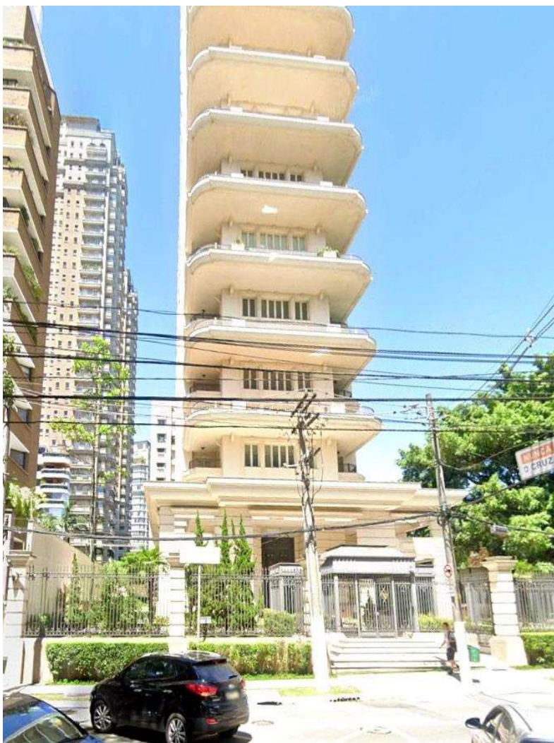
Foto 1 – Vista da Fachada do Edifício
