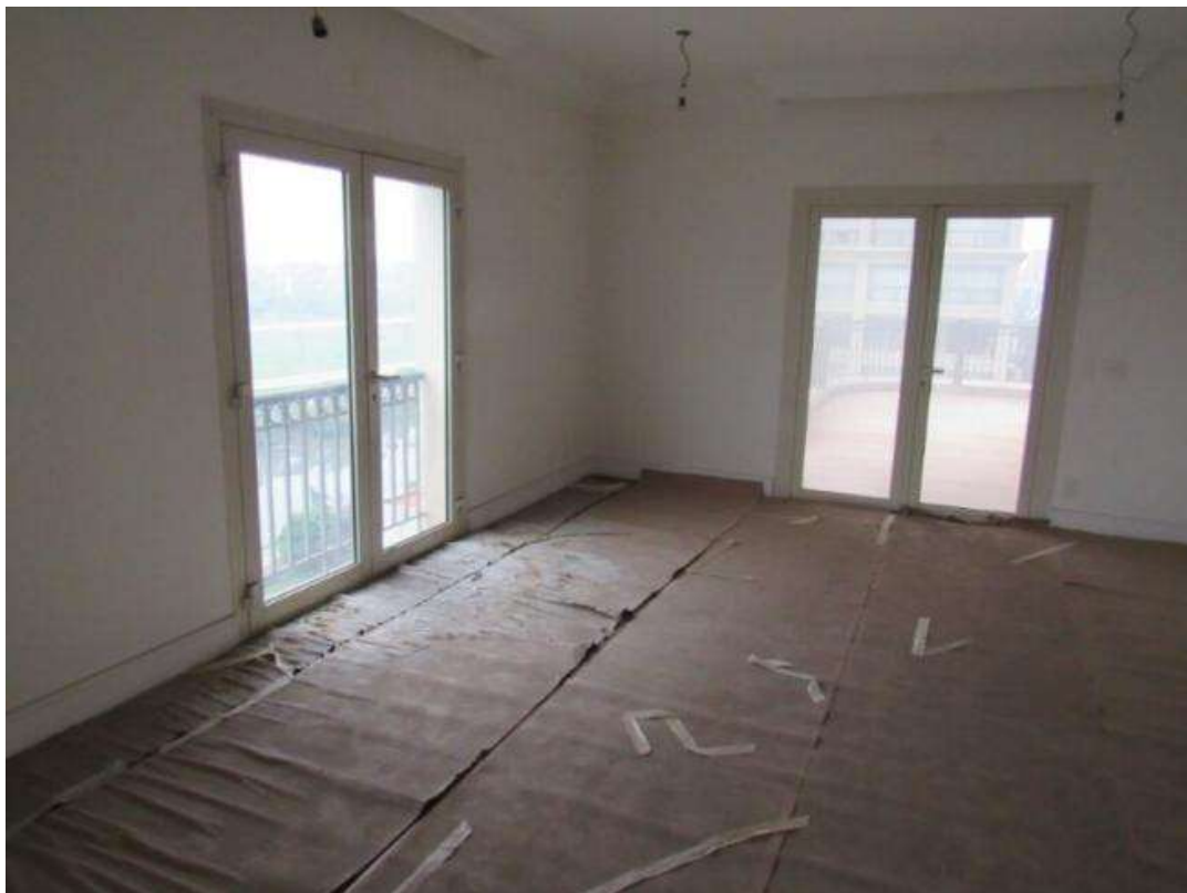
Foto 38 - Sala de jantar no pavimento inferior do apartamento
