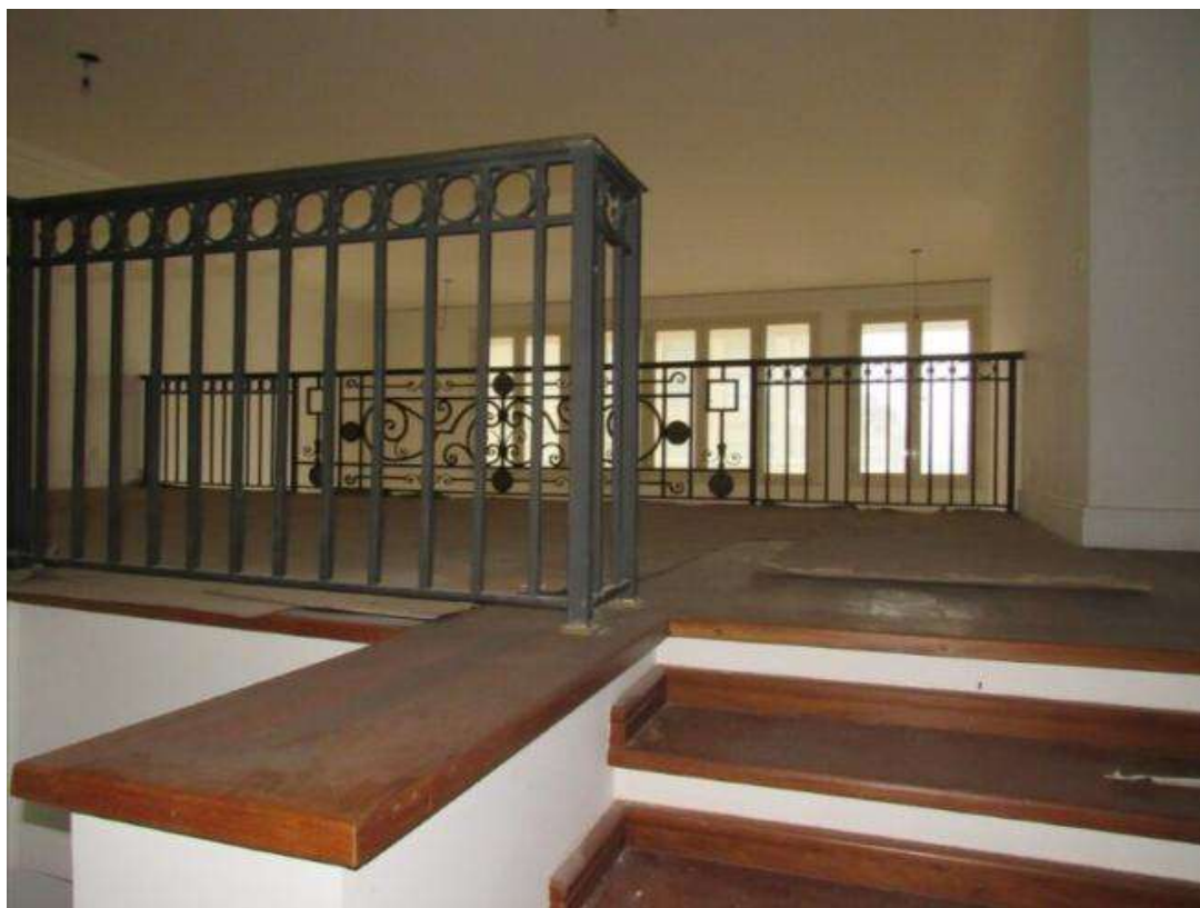
Foto 49 – Detalhe das escadas e Mezanino
