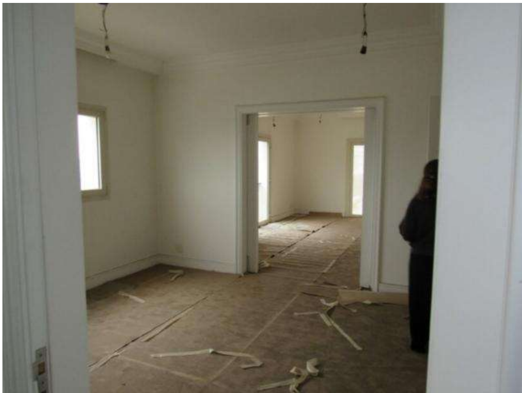
Foto 34 – Sala de jantar no pavimento inferior do apartamento
