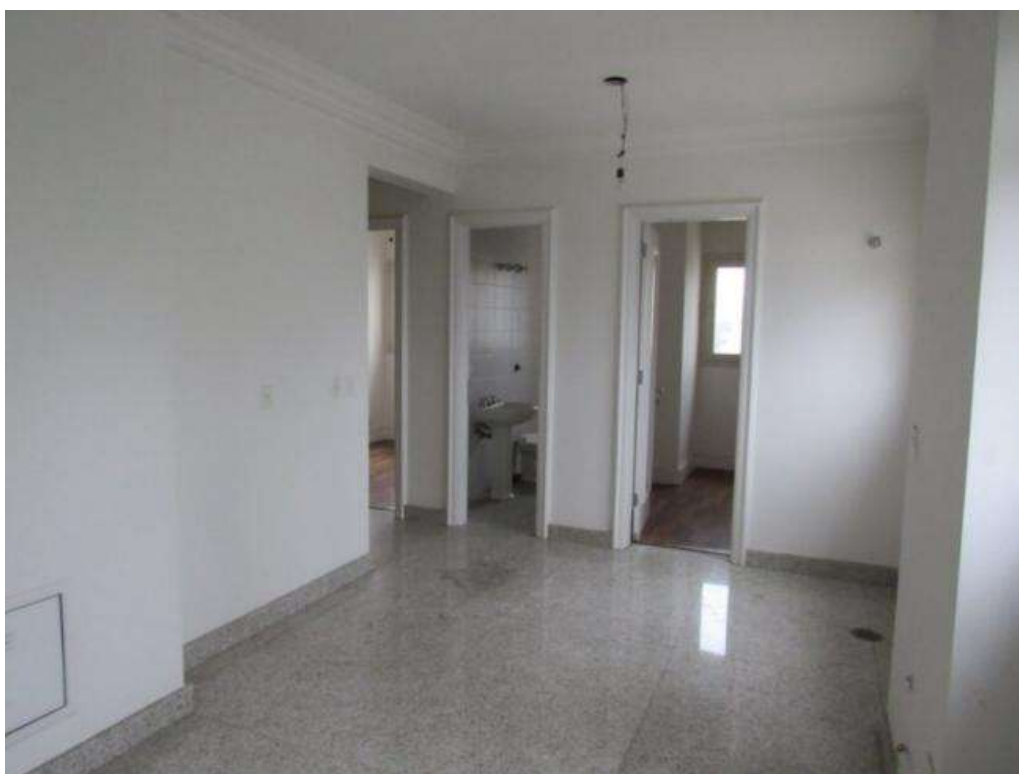
Foto 25 - Área de serviço no pavimento inferior do apartamento
