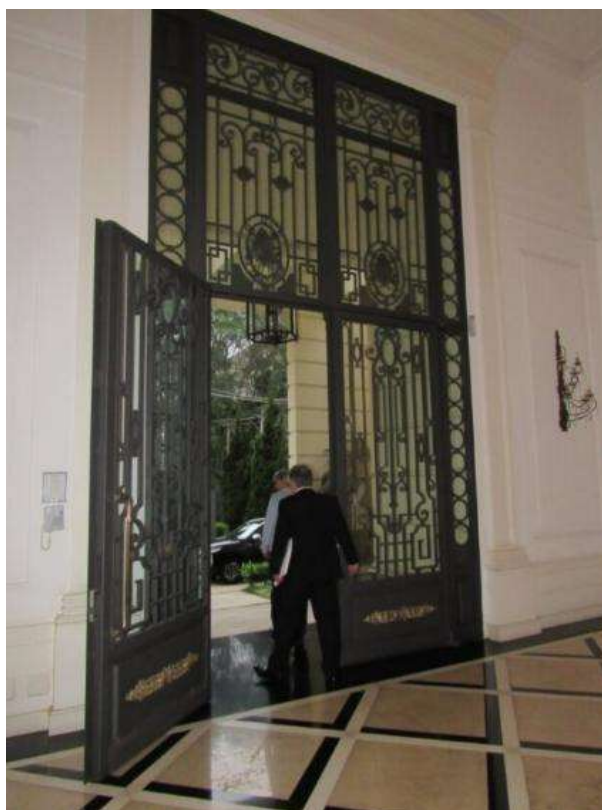
Foto 7 – Entrada do Edifício
