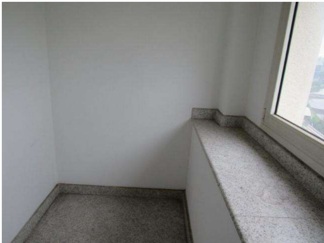
Foto 30 – Despensa no pavimento inferior do apartamento
