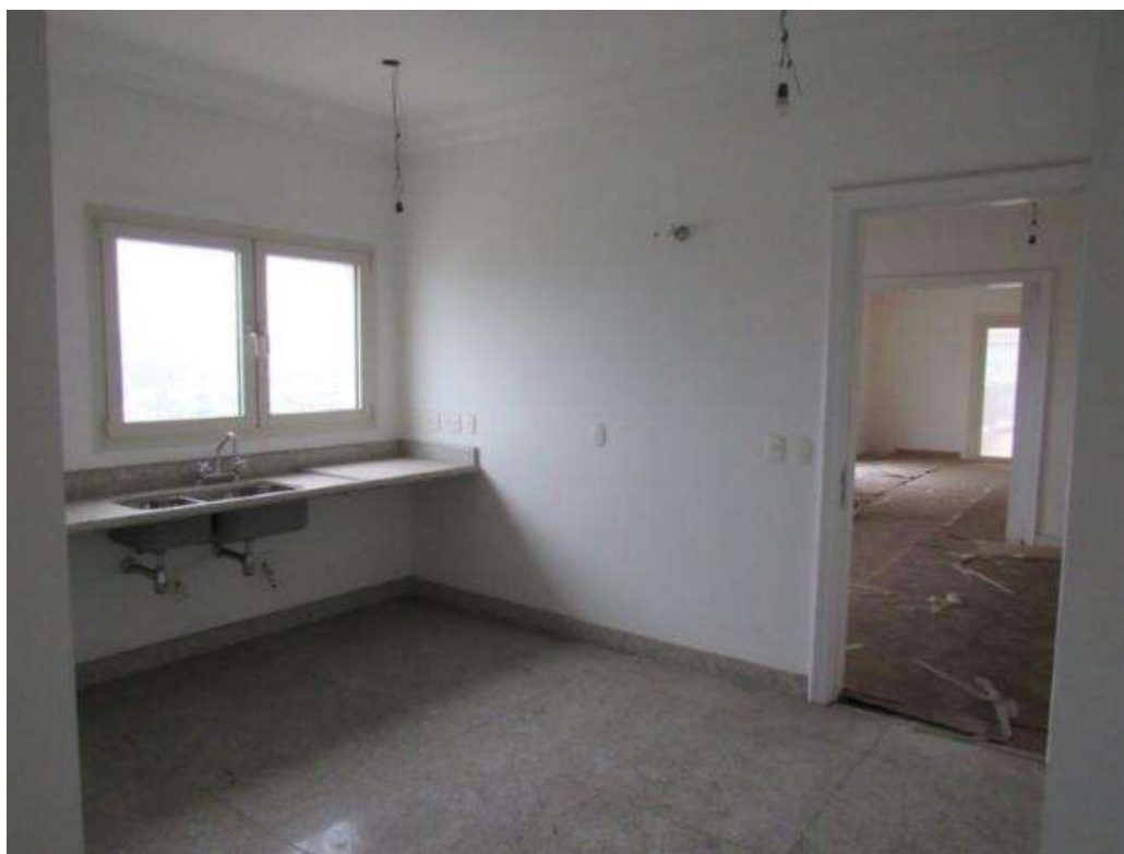
Foto 27 - Cozinha no pavimento inferior do apartamento
