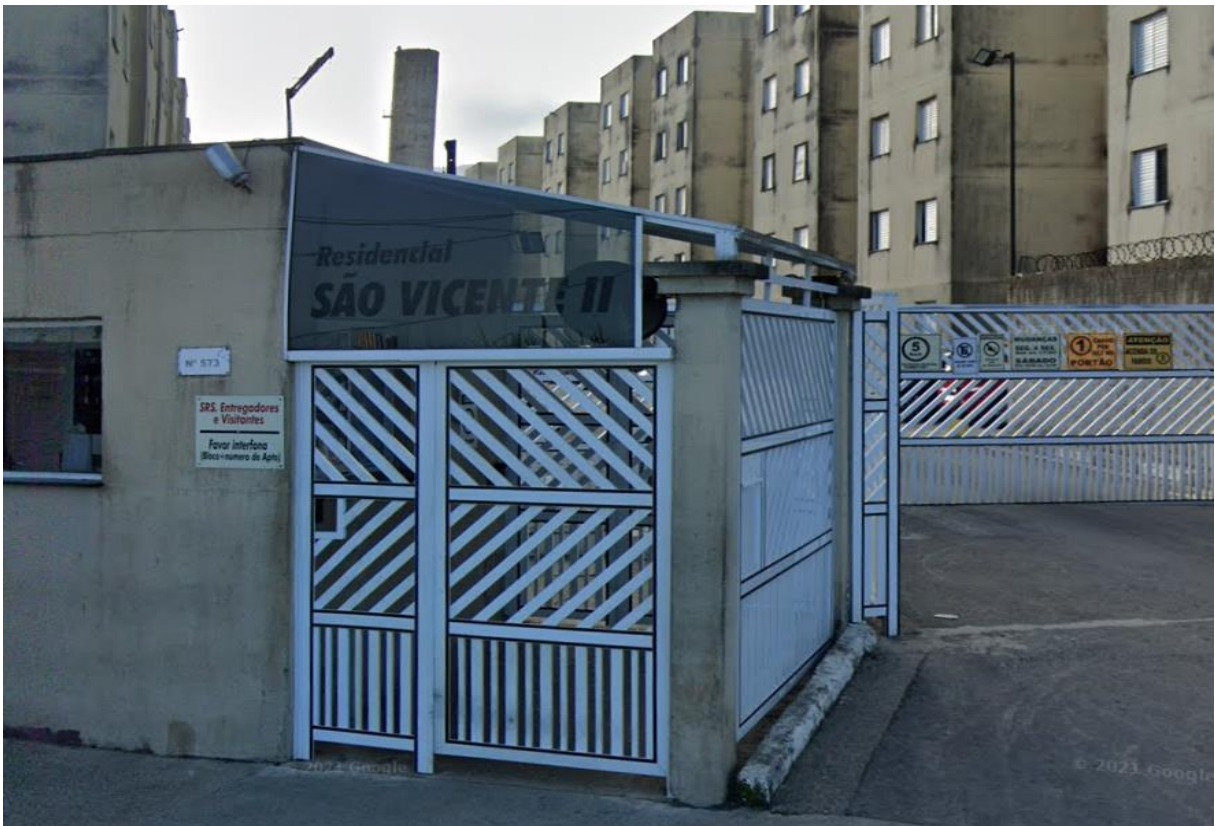
FOTO 04 - Detalhe da Portaria de Entrada do Condomínio Residencial São Vicente II de frente para a Rua Antônio Victor Lopes nº 573.
