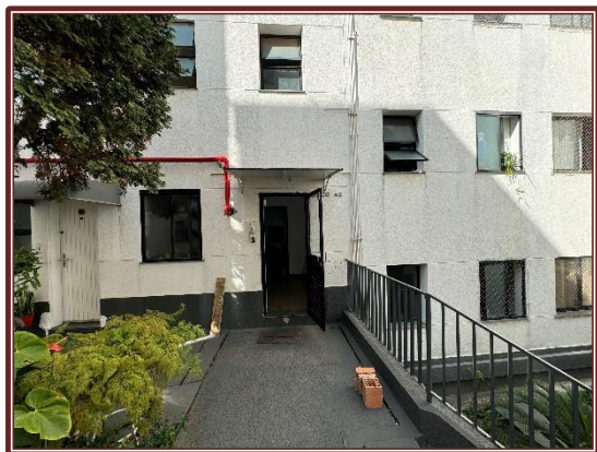
↑ Foto nº 09: Vista do acesso ao bloco.
