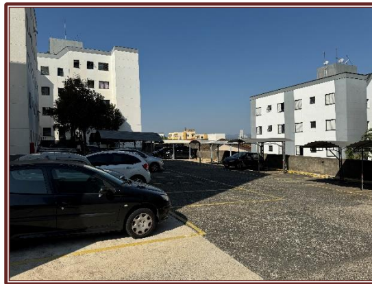
↑ Foto nº 10: Vista da área de garagens.
