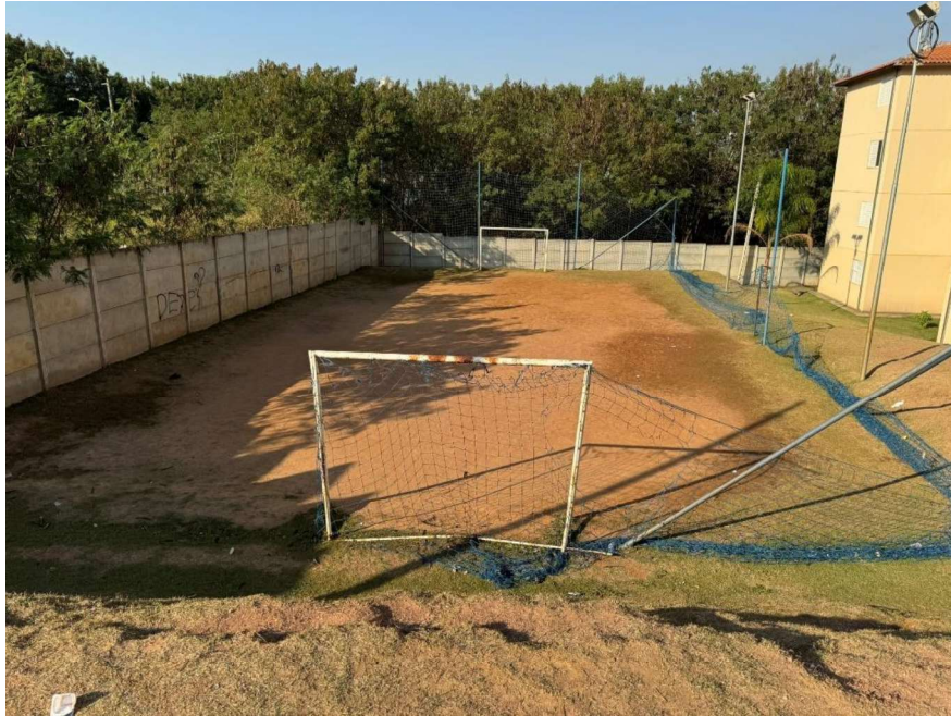
VISTA DA QUADRA.
