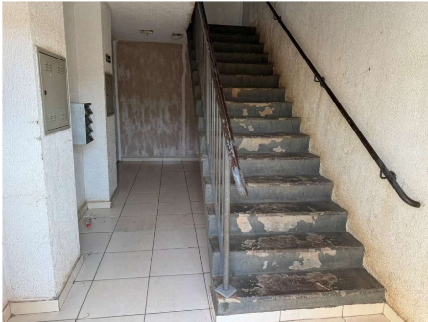
VISTA DO HALL.
