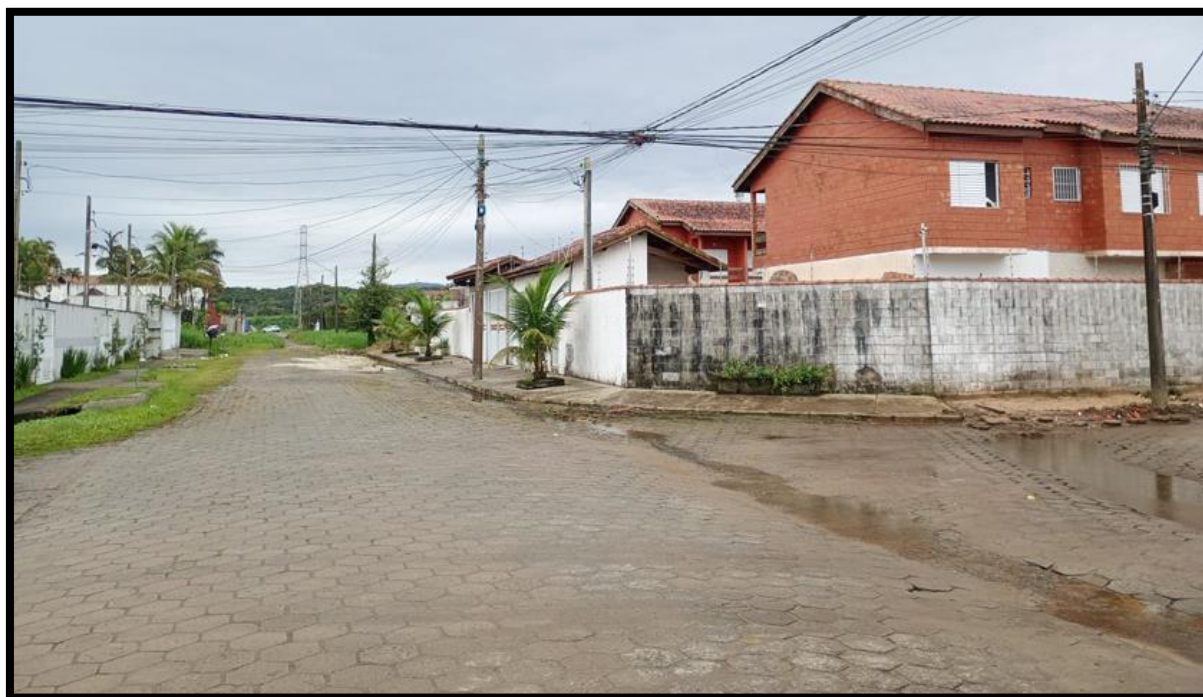
Figura 7 - infraestrutura urbana em frente ao imóvel
