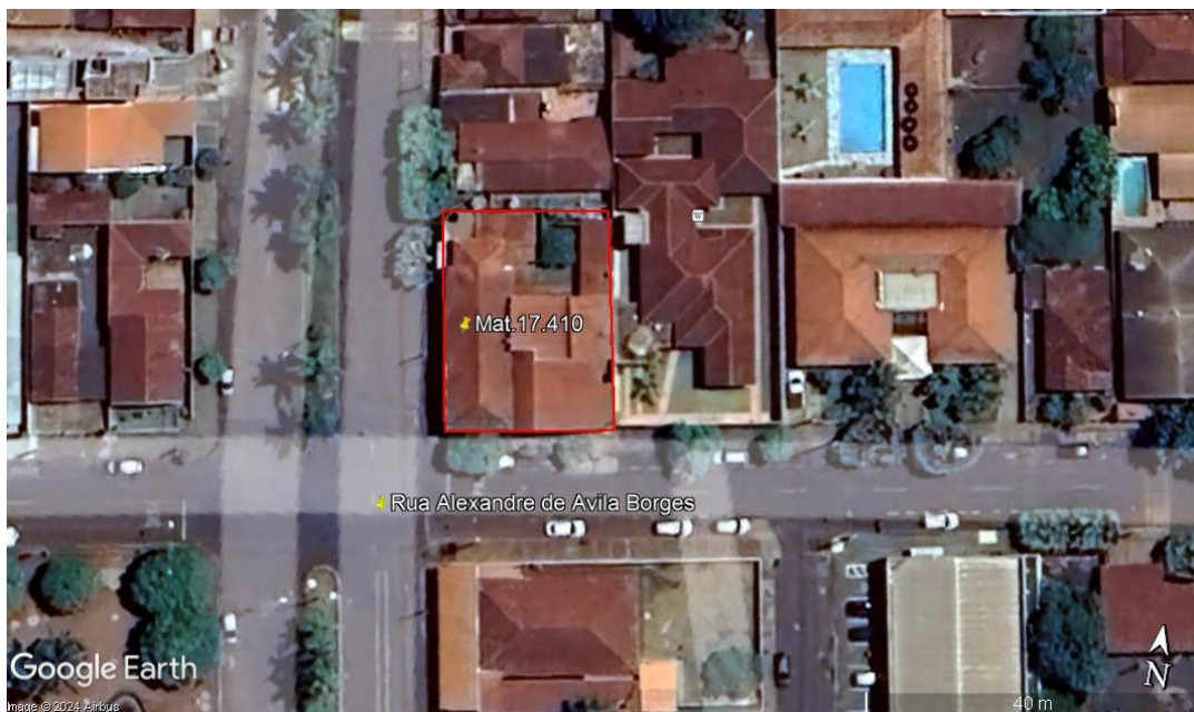
Figura 4 - Vista Panorâmica do Imóvel Avaliando. Fonte. Google Earth Pro.
