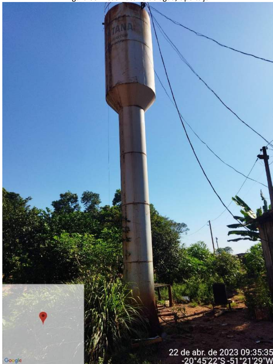
Figura 35: Reservatório de água, tipo taça.
