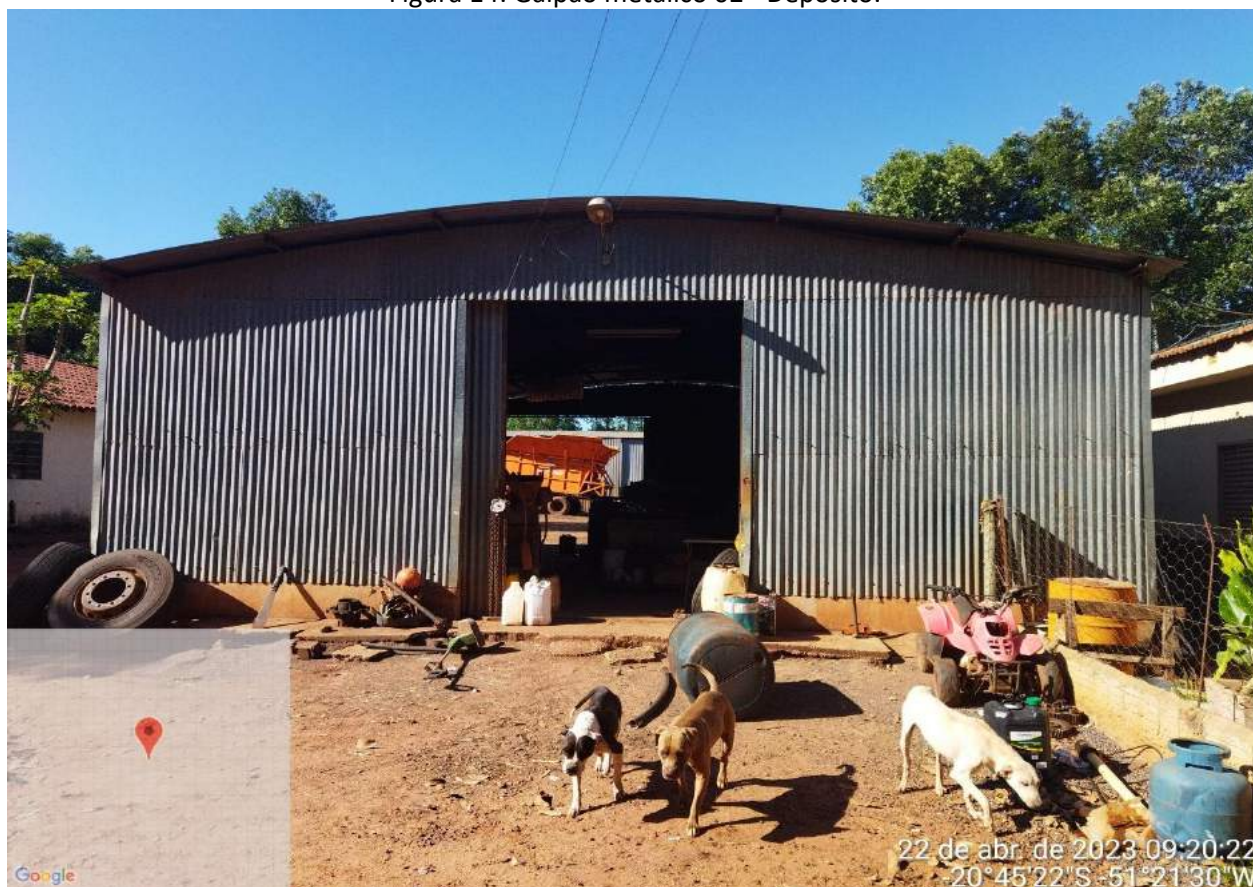
Figura 14: Galpão metálico 02 - Depósito.
