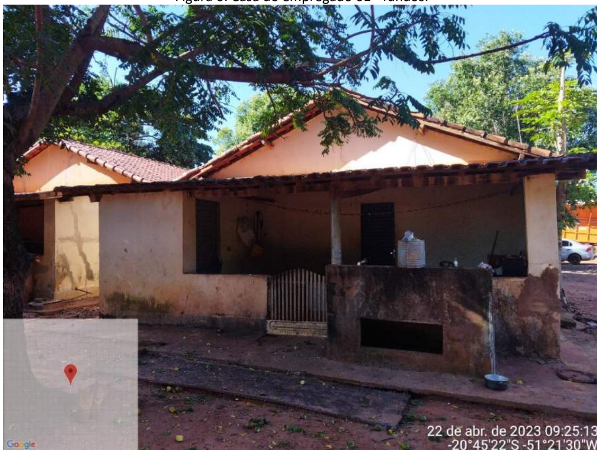
Figura 6: Casa do empregado 01 - fundos.
