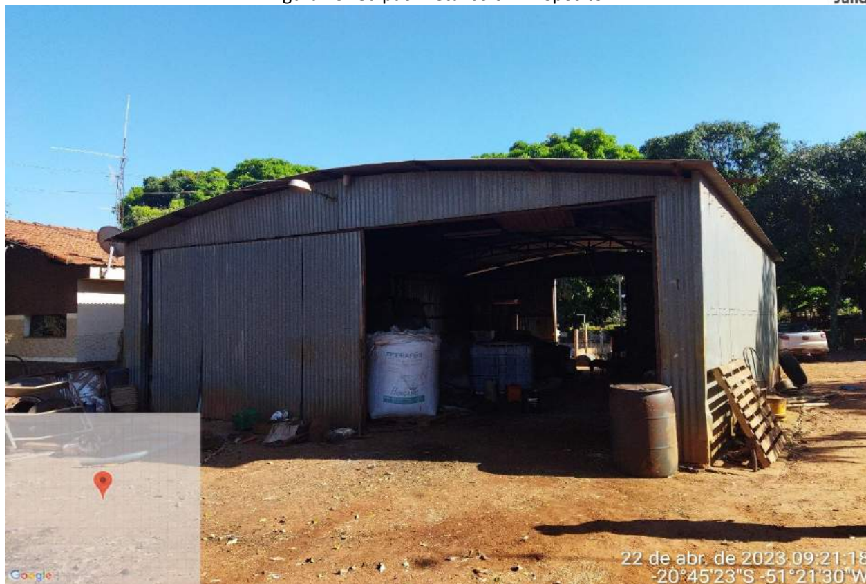
Figura 13: Galpão metálico 02 - Depósito.
