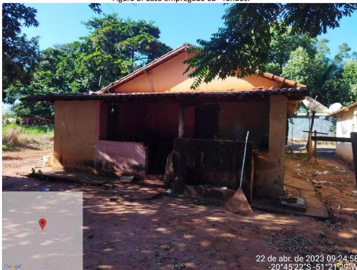
Figura 8: Casa empregado 02 - fundos.
