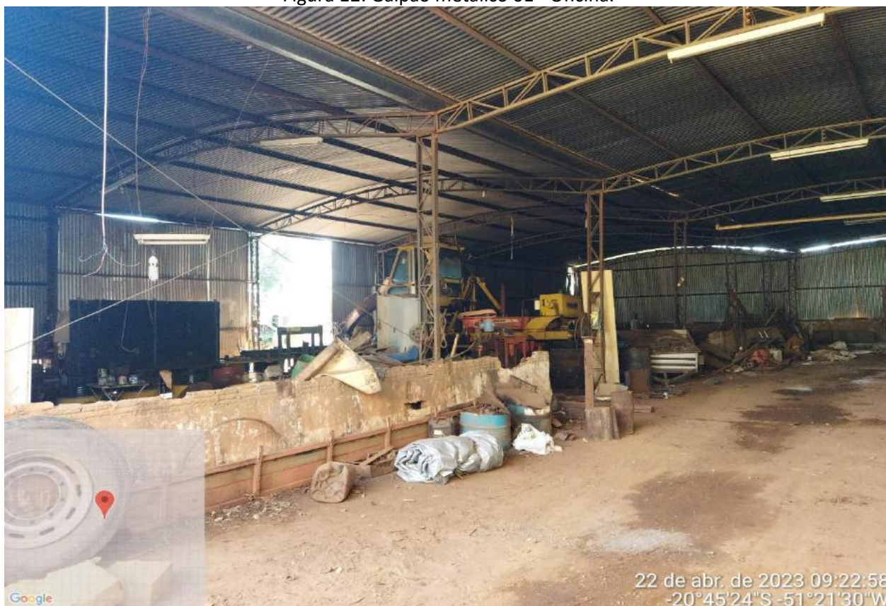
Figura 12: Galpão metálico 01 - Oficina.
