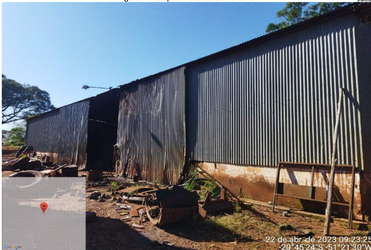
Figura 11: Galpão metálico 01 - Oficina.
