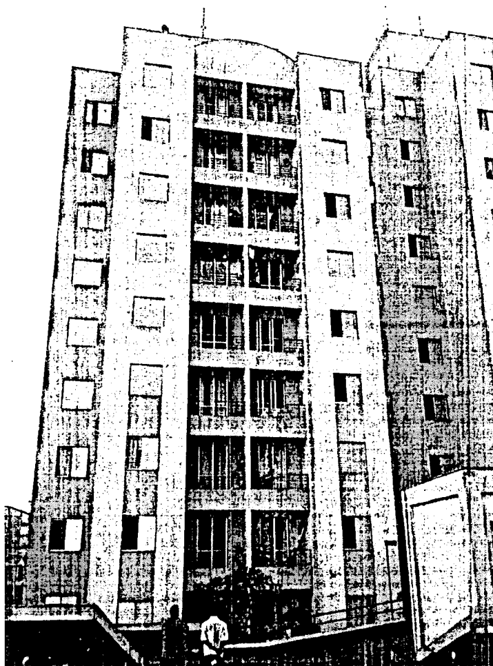
FOTO 8: VISTA GERAL DO PRÉDIO ONDE ESTA SITUADA A UNIDADE EM QUESTÃO.
