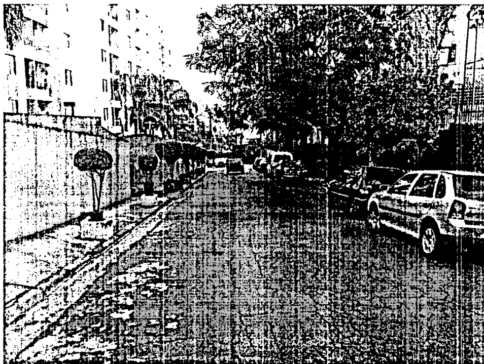
FOTO 2: RUA JOSÉ FERREIRA DE CASTRO EM SENTIDO CONTRÁRIO.
