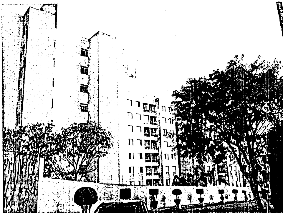
FOTO 5: VISTA GERAL DO CONDOMÍNIO.
