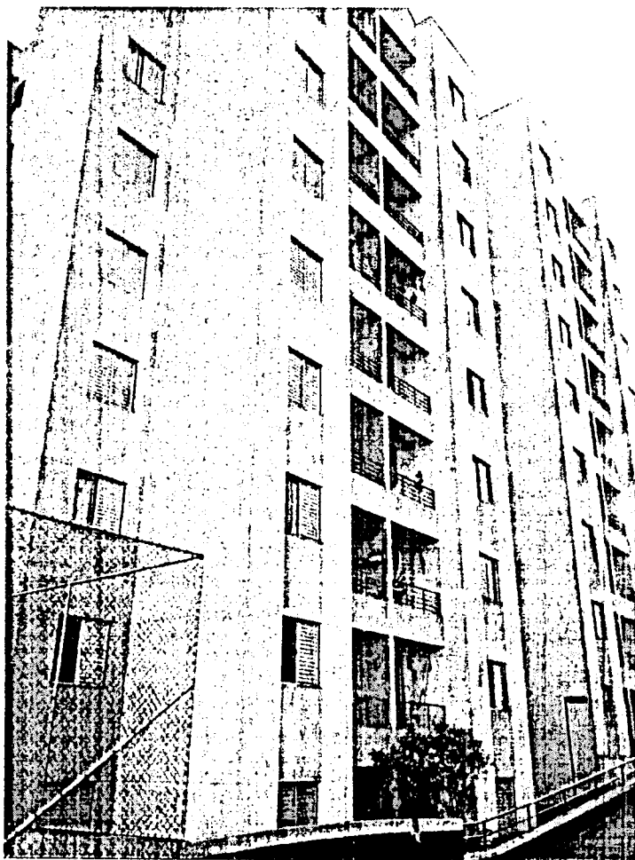
FOTO 7: PRÉDIO ONDE ESTÁ SITUADA A UNIDADE AVALIANDA.
