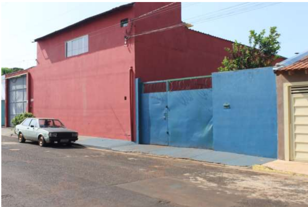
Foto 01: Fachada” do imóvel nº848 ,lote 04 quadra 08 Jardim Esmeralda
