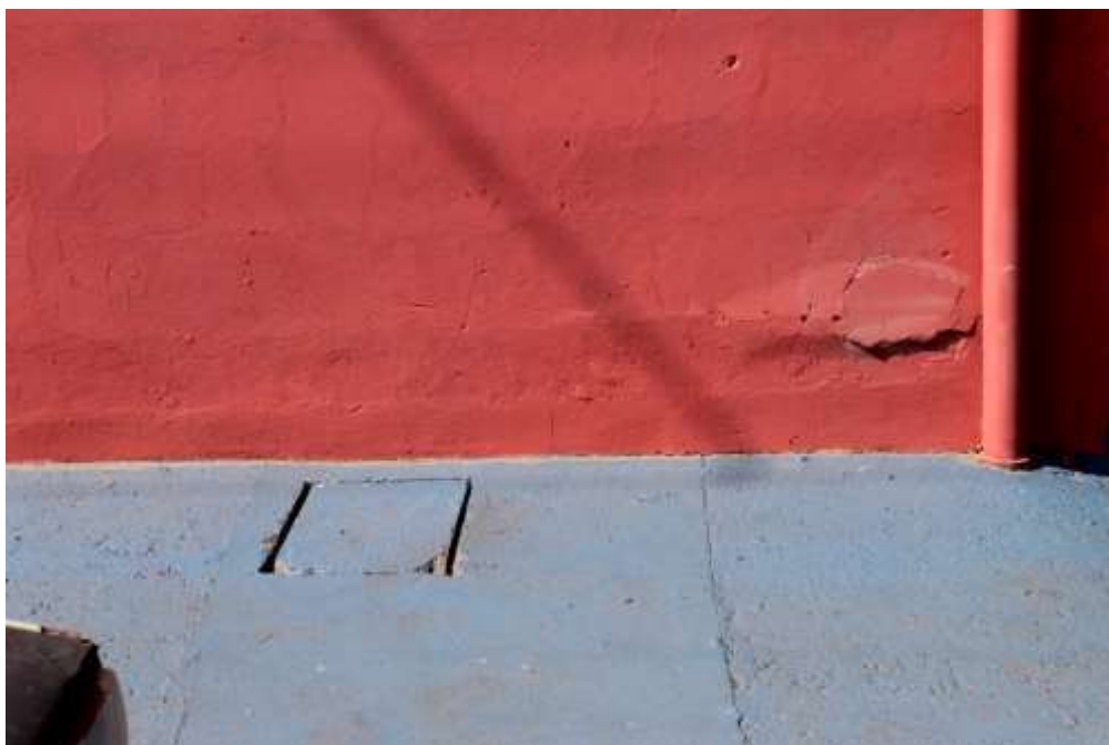
Foto :Caixa de esgoto terreno 04 lote 08 ,
