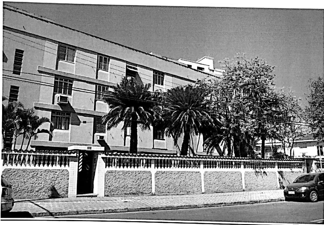
FOTO 01 :- Vista geral do imóvel.
